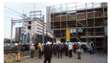
仮線の横で進む高架化工事を見学
