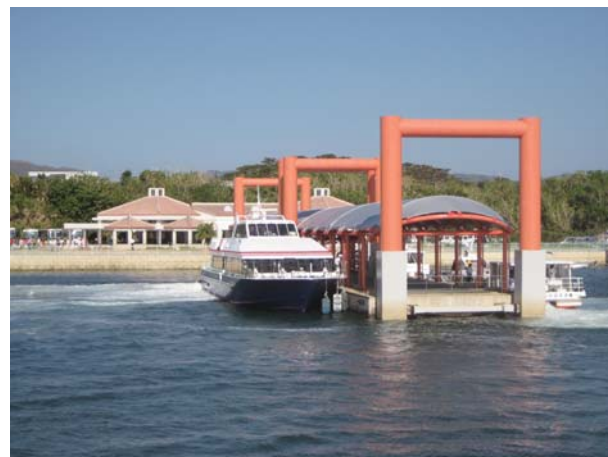
浮棧橋整備事業／仲間港(竹富町)
