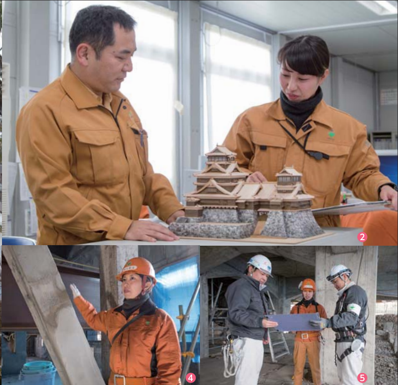
① 工事現場へ続くスロープで土山所長と共に。② 熊本城のモデルの前で工事長と作業工程について話し合う。③ 工事現場の足場から熊本市街を眺める。④ 天守閣1階の柱の状態を説明。⑤ 躯体の調査と補修を担当する職長さんと図面を用いて打ち合わせ。
