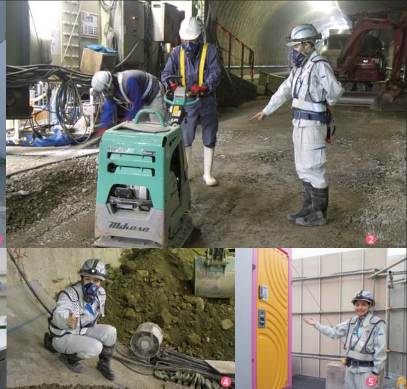
①トンネル坑口前で伊藤所長と共に。②トンネル内のインパートの埋め戻し転圧を指示・確認。③工事長と各種工事情報をパソコンでチェックする。④インパートの埋め戻しの高さを目視確認中。⑤作業現場に設置された女性用トイレ。
