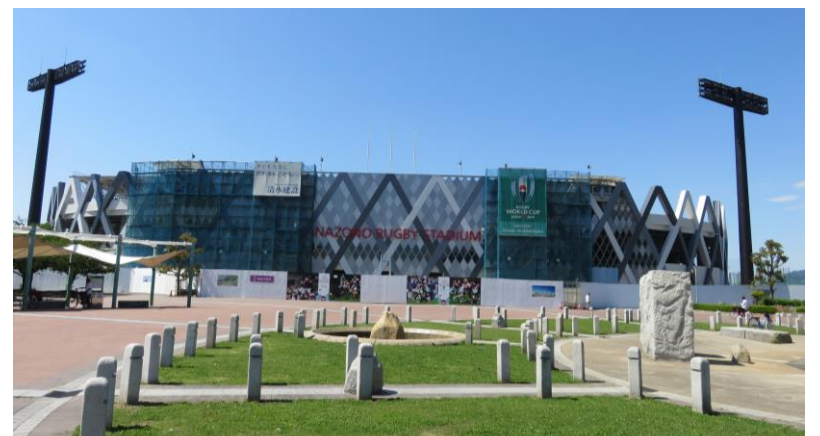
施工状況写真(南立面)
