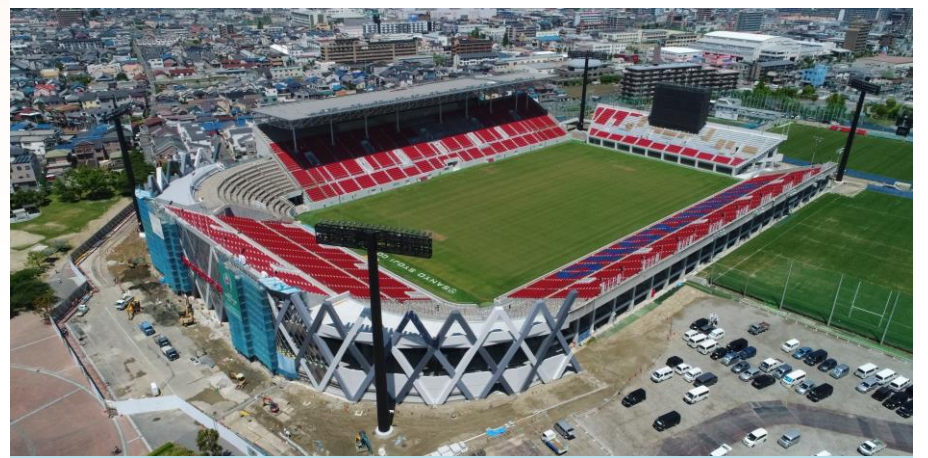
施工状況写真(南東面)
