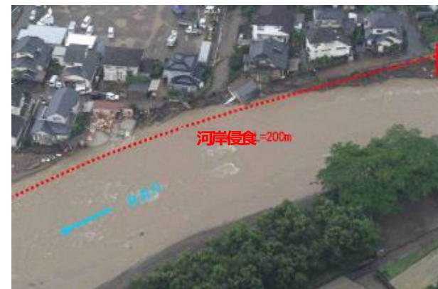
河岸侵食に伴う家屋倒壊
