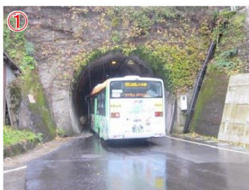
すれ違いが不可能なトンネル
