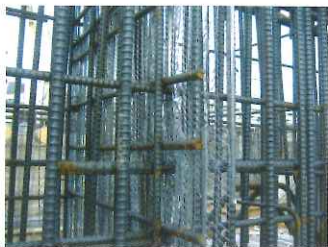
打ち継ぎラス施工
