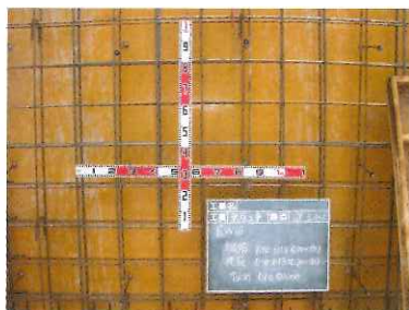
工事写真〈配筋写真〉
