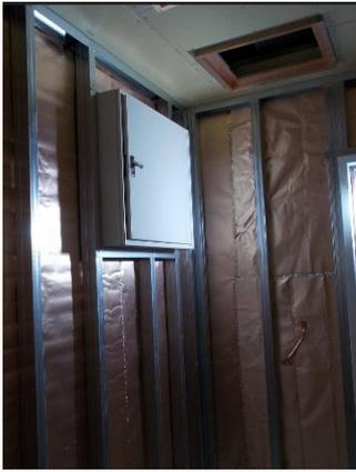
写真1 壁銅箔張状況<sup>5)</sup>
