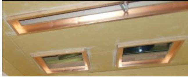
写真2 天井器具廻り銅箔張状況<sup>5)</sup>
