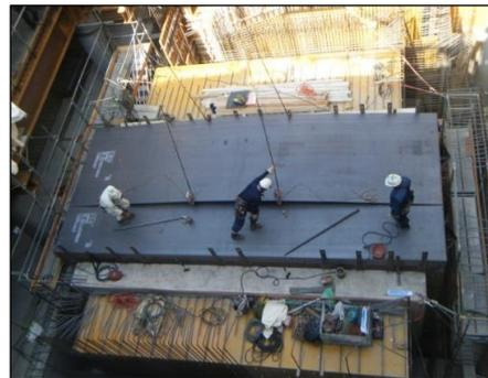
写真4 スラブ面遮へい鋼板設置
