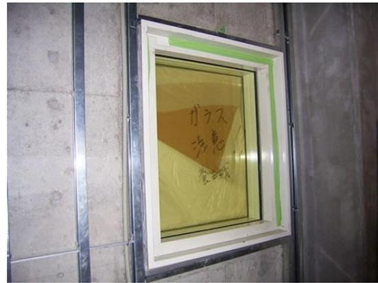
写真1 鋼製放射線防護建具枠回りの納まり例<sup>4)</sup> 写真2 遮へい用鉛ガラス窓の例<sup>4)</sup>
