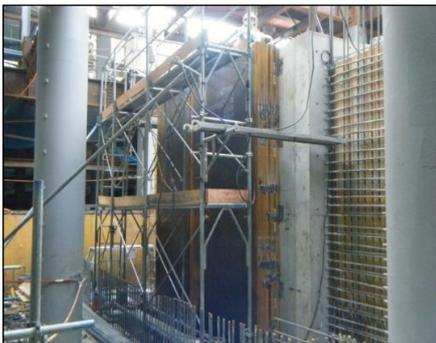
写真3 壁面遮へい鋼板設置
