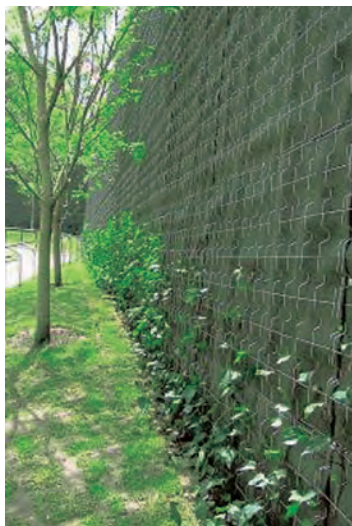
写真1 薄層緑化 (トラブル事例の薄層緑化とは関係なし)
