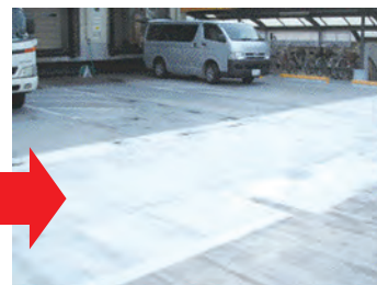
写真3 事例②の塗膜防水補修後の状態
