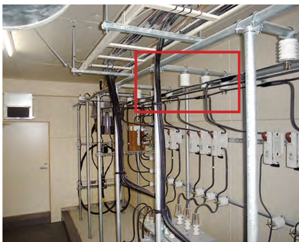
写真1 鋼製ラックの支持状況
