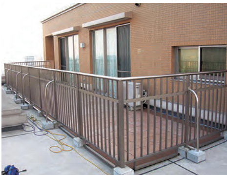
写真 2 横格子・バットレス設置完了後
