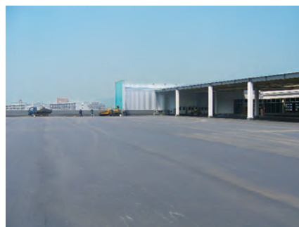
写真 5 アスファルト舗装仕上げ
