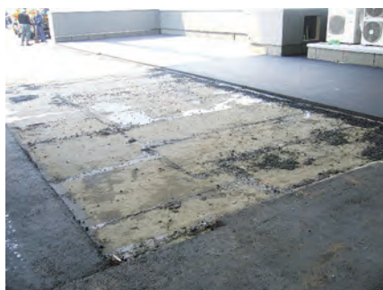
写真 4 合成床版上へのアスファルト防水
