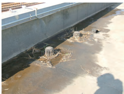
写真1 漏水部分屋上ドレン周りに生えていた雑草が除去された状況
