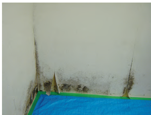
写真1 結露によるカビの発生
