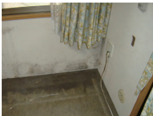
写真1 結露によるカビの発生
