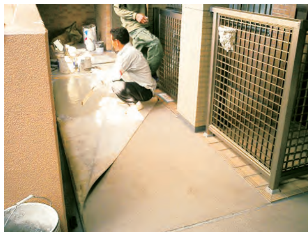
写真2 廊下床の補修状況
