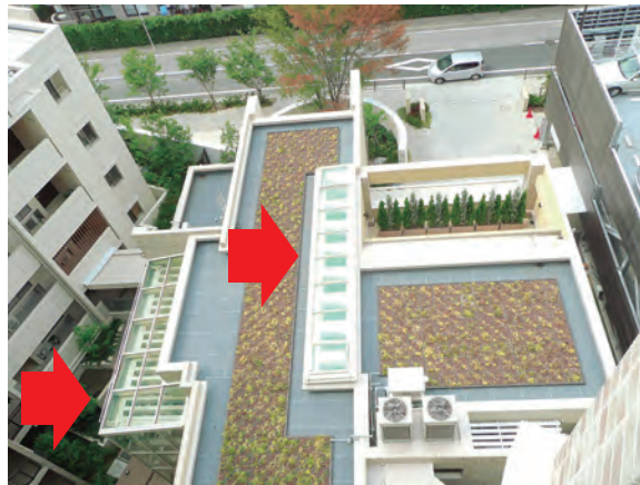
写真1 屋上へのトップライト設置例 （トラブル事例のトップライトとは関係なし）
