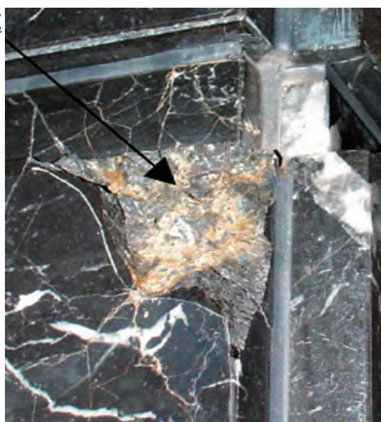
写真3 石の自然破損
