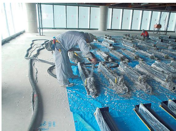
写真4 自然換気装置を個別に断熱施工している状況
