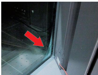
写真3 サッシ枠コーナー付近のガラス結露
