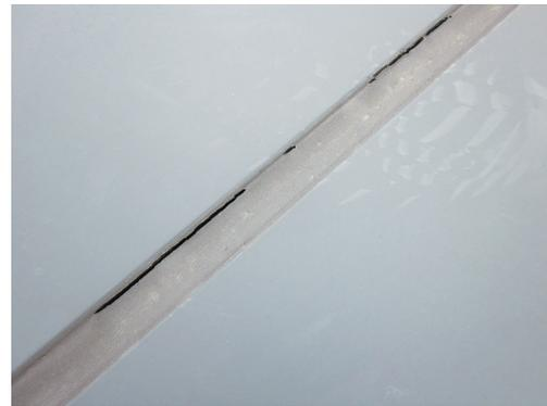
2成分形の変成シリコン系シーリング材の温度ムーブメントによる設計伸縮率は 20%、設計せん断変形率は 30% です。
