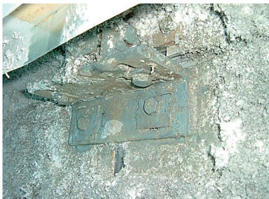
写真1 PCa板に固定されたアングル
