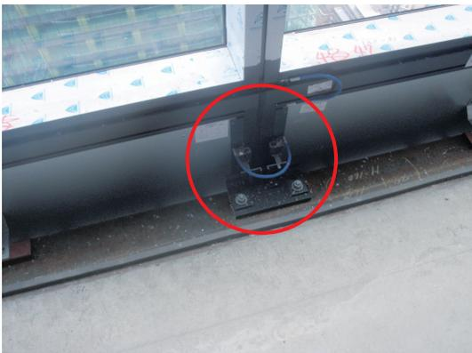
写真4 ACWを受雷部としたときの室内側導線の例
