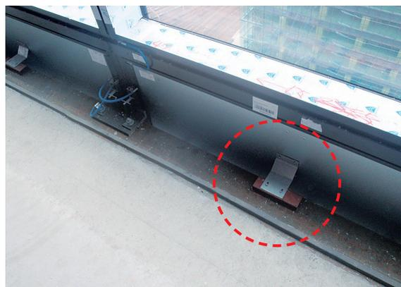
写真2 耐火パネルの固定例（層間ふさぎなどは未施工の段階）
