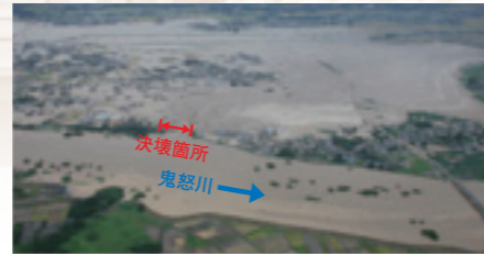
鬼怒川の氾濫の被災状況(全景写真)
