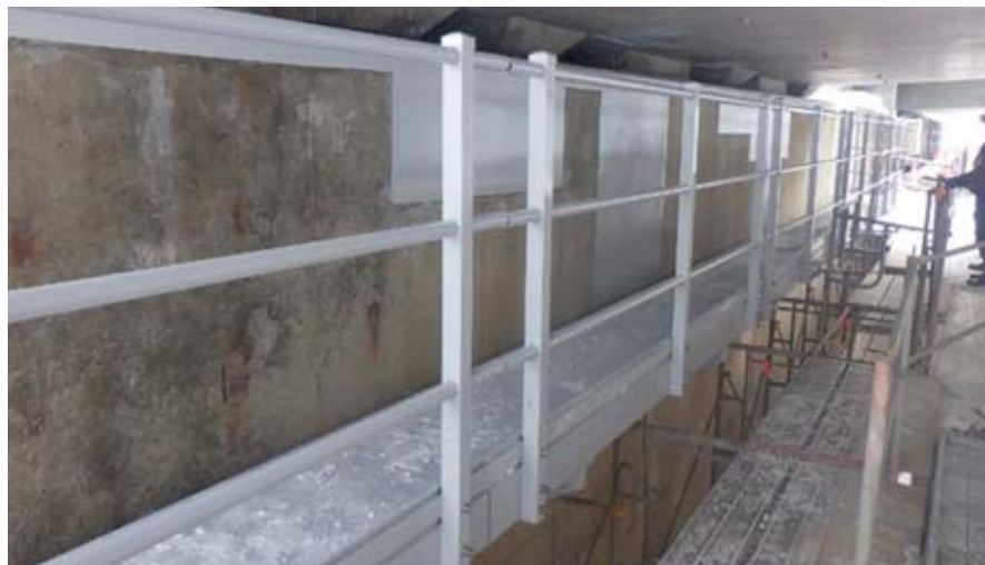
写真-3 FRP検査路設置
