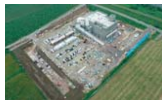
写真-5 地上建屋工事
