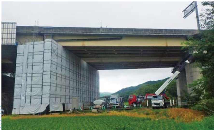
写真-1 ウォータージェット施工状況
