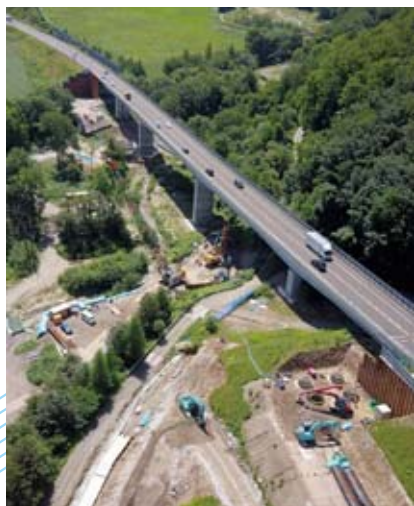
写真-3 ベンケオタソイ川橋全景
