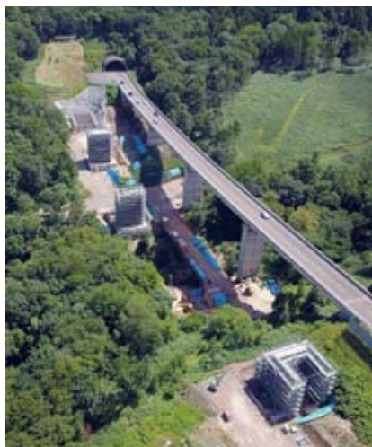
写真-2 広内川橋全景
