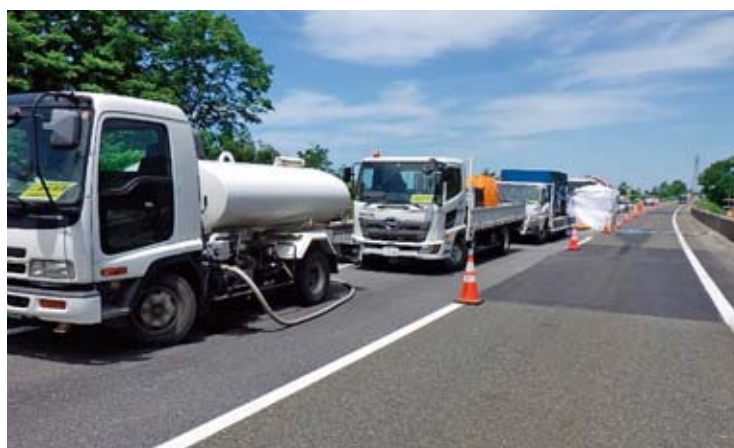
写真-2 本線上、伸縮装置取替
