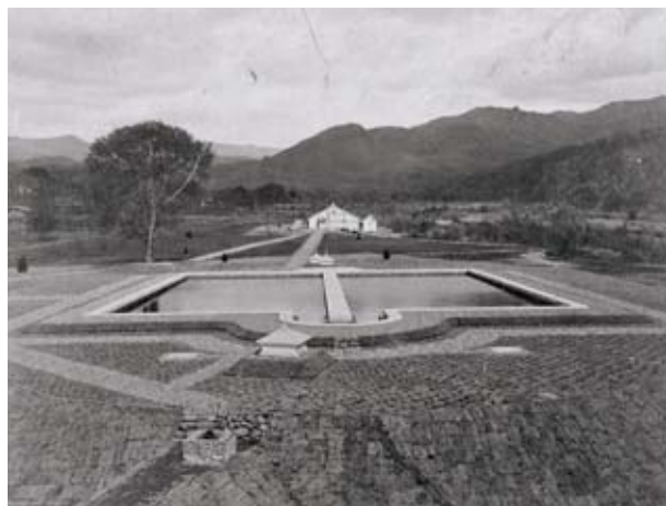
赤川高区浄水場
