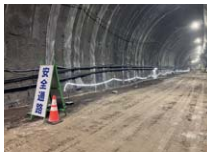
写真-4 LEDによる通路の可視化
