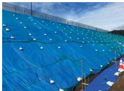
写真-5 供用線への飛散防止
