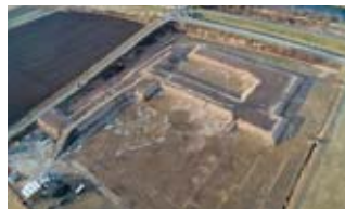
写真-2 圧密沈下工事
