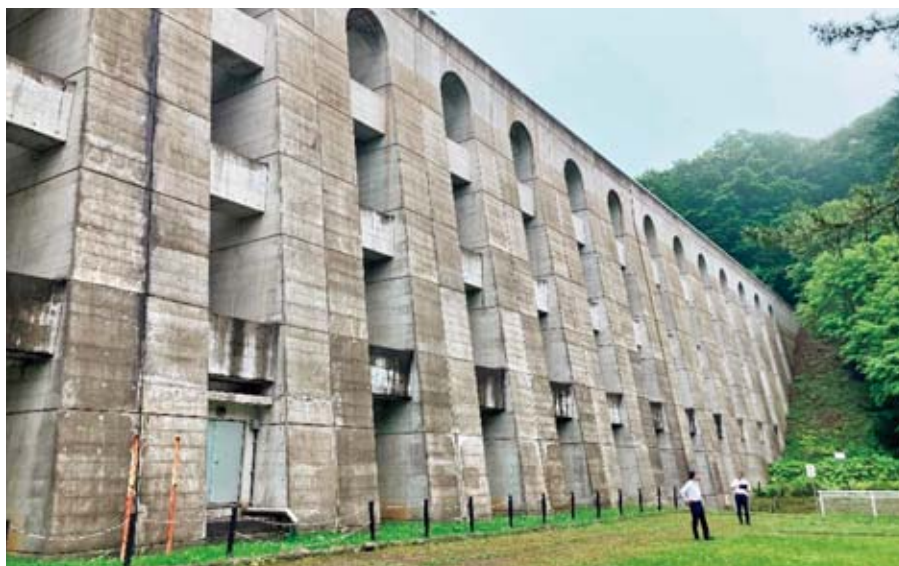
現在の笹流ダム（下流側より）
