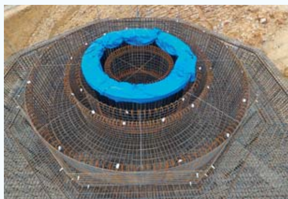
(写真1) 基礎の鉄筋は写真のように複雑に組まれています。鉄筋総重量で70t以上もありますが、この現場では組立に1日6～7人作業で10日ほどで完了します。
