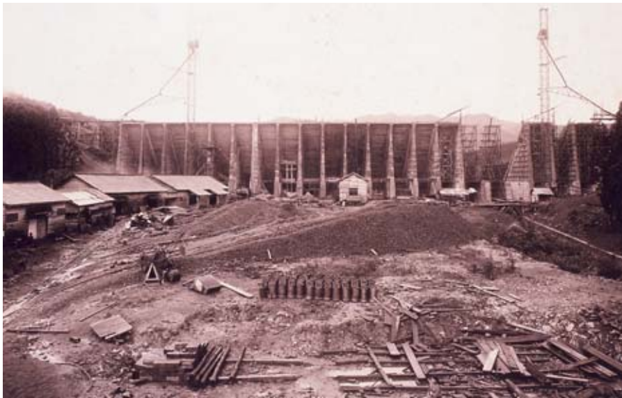
建設中の笹流ダム（下流側より）
