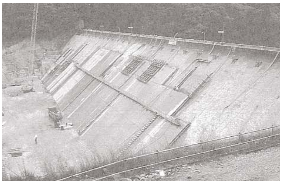
第2次改修工事（上床版コンクリート打設）
