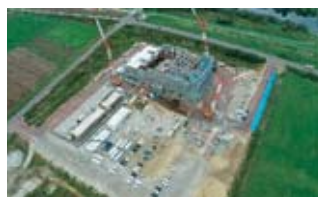
写真-4 地上建屋工事
