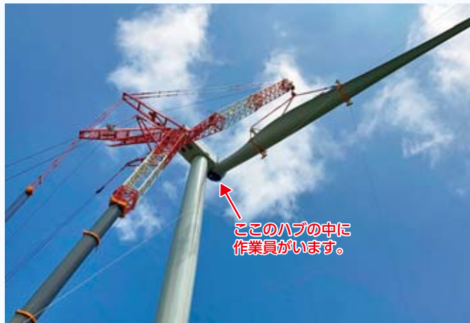
（写真7）空中でハブにブレードを取り付けています。ハブの中に作業員がいて、手作業で取り付けしています。
