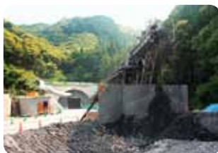
ベルトコンベアによるずり搬出状況
