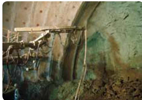
吹付け施工状況
