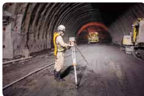
粉じん濃度測定状況
