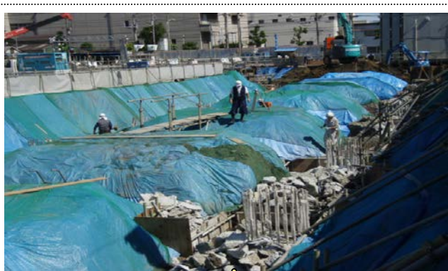
杭頭処理したコンクリート塊
