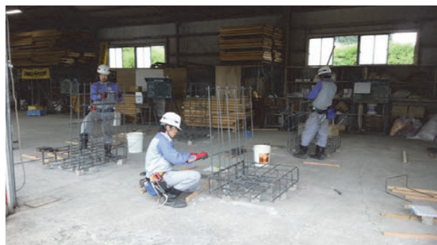
鉄筋組立実習
