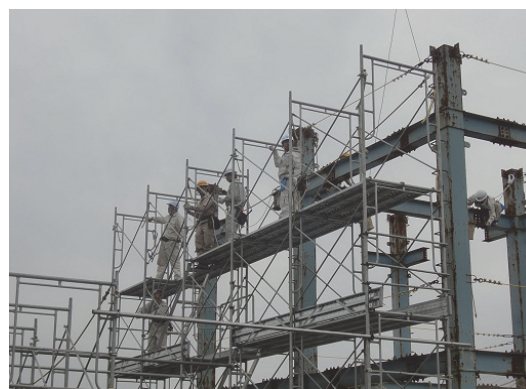
仮設足場組立実習
