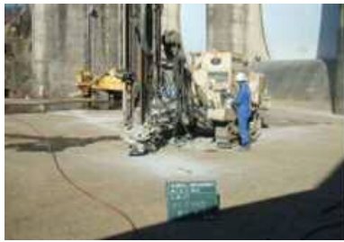
ラインドリリング状況
