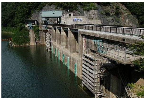
菌原ダム現況 1)
