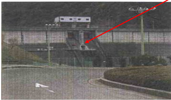
工事完了全景
