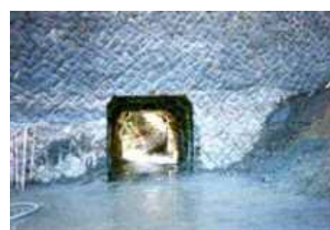
美敷ダムの穴あけ後の状況 (SD施工工期:1995.11~1995.12)
