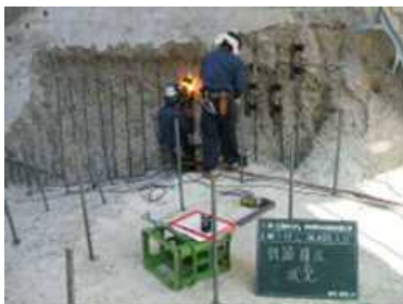
鉄筋圧接状況
