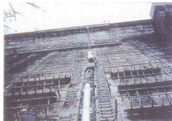
⑦ 堤体背面部導水管吊込み状況
