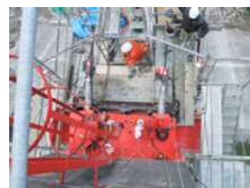
アンカー設置状況
