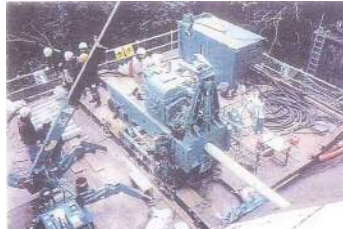
④ パイロット孔の削孔
