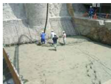
コンクリート打設状況
