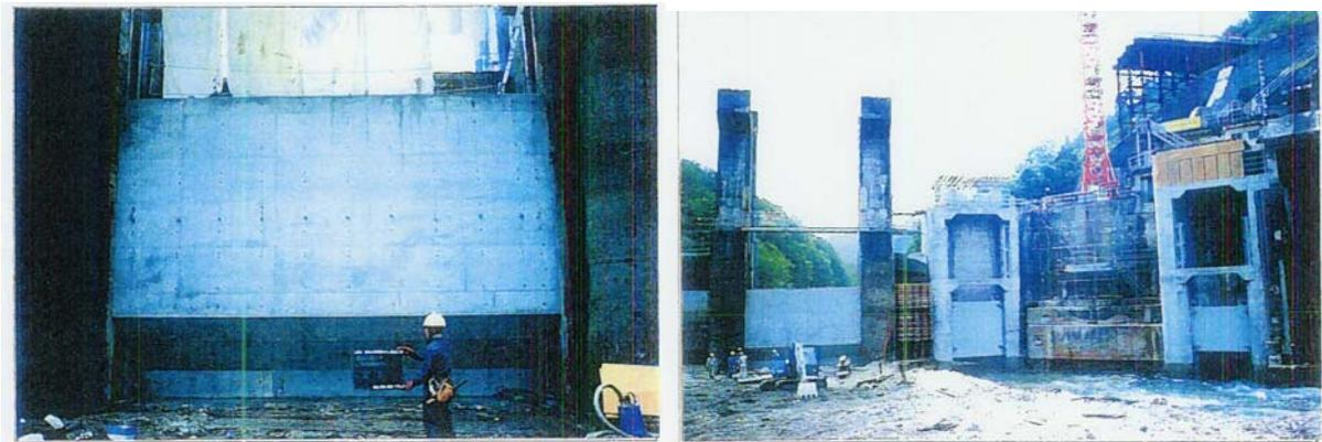
図-2.5.20 仮締切り施工状況<sup>2)</sup>
