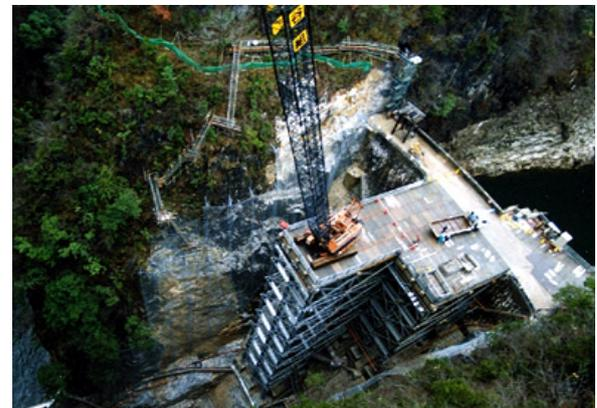
図-2.4.14 ダム下流面仮設構台<sup>13)</sup>
