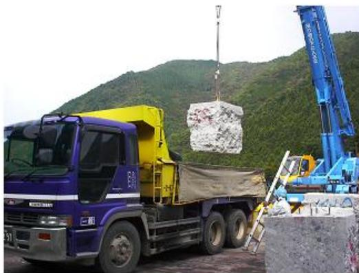
図-2.4.37 取壊しブロック搬出状況
