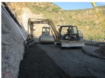
図-2.4.28 締固め状況（旧堤体接続部）
