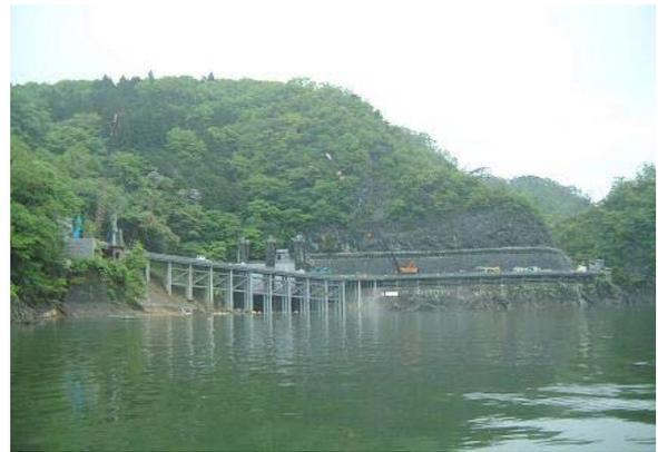
図-2.4.12 貯水池内仮設構台<sup>12)</sup>
