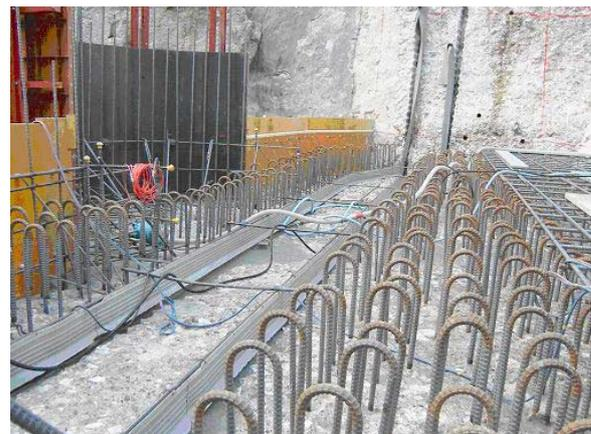
図-2.4.15 新堤体の補強鉄筋状況<sup>12)</sup>
