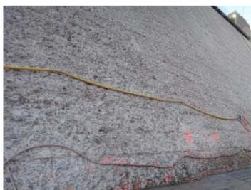
図-2.4.26 既設ダム下流面処理状況
