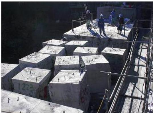
図-2.4.36 既設堤体天端部切り出し状況<sup>7)</sup>
