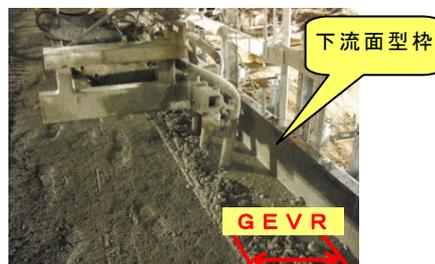
図-2.4.29 締固め状況（下流面）
