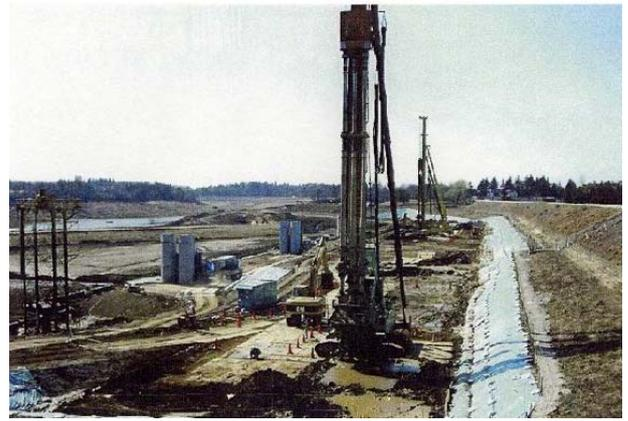
图-2.3.17 第1堰堤 SMW 施工状况<sup>4)</sup>
