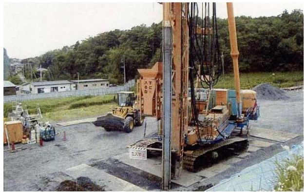
图-2.3.18 第1堰堤 GCP 施工状况<sup>4)</sup>
