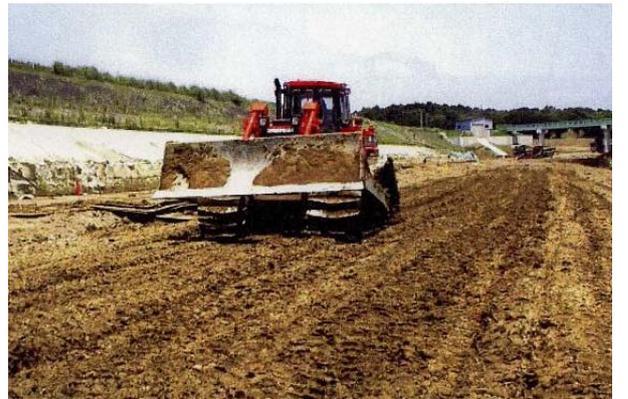
图-2.3.19 第1堰堤上流復旧盛土施工状况<sup>4)</sup>
