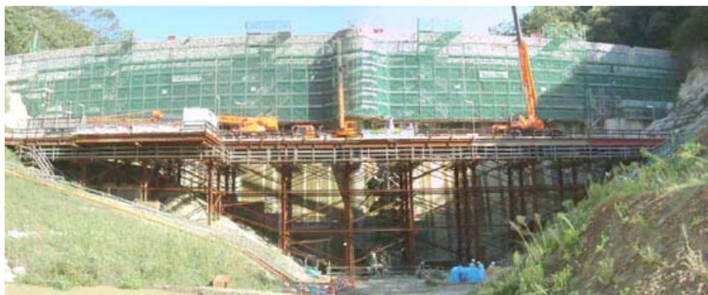
図-2.3.1 布引五本松堰堤の作業用構台<sup>1)</sup>
