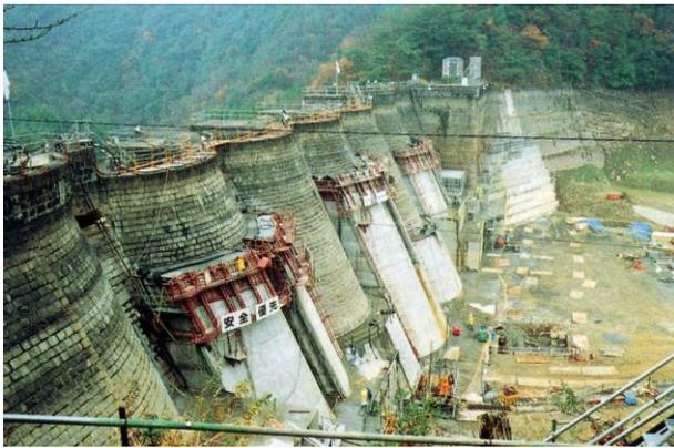
図-2.2.13 堤体上流面補修状況<sup>7)</sup>
