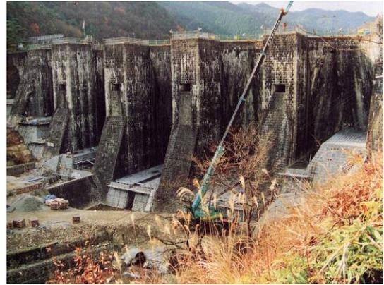
図-2.2.14 堤体下流面補修状況<sup>7)</sup>
