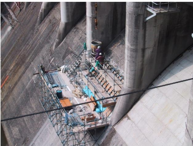
図-2.2.9 エプロン施工状況<sup>15)</sup>
