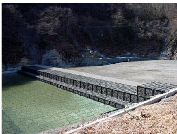
図-1.4.8 下久保ダムの鋼製枠構造の貯砂ダム<sup>10)</sup>
