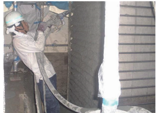
写真-2 モルタル吹付け状況
