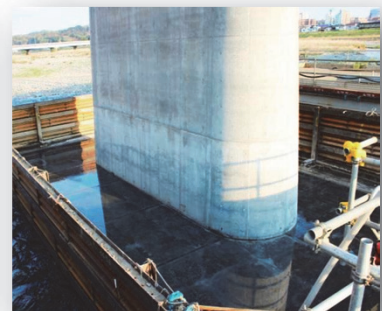
摩耗対策完了
