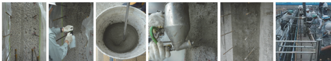
打継処理の施工フロー図(既設コンクリートの増し打ちの場合)
