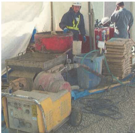
写真-1 モルタルプラント
