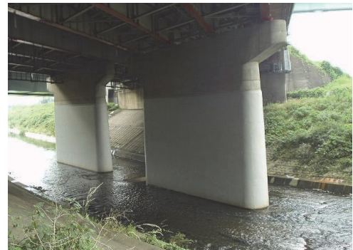
写真-3 河川内橋脚の施工例
