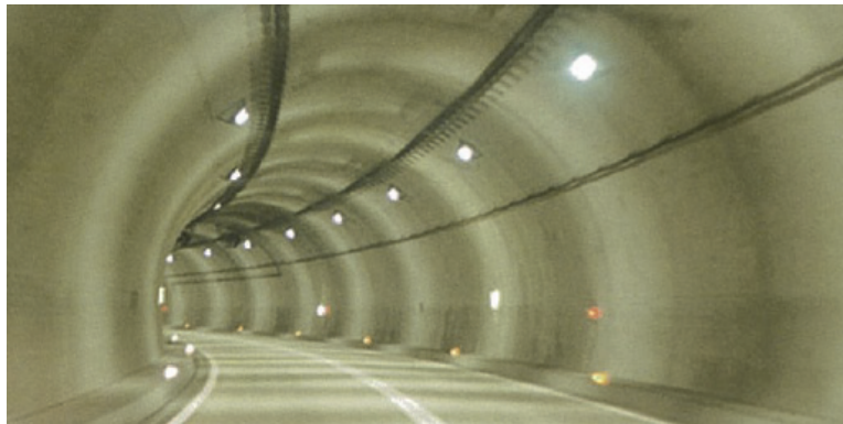
N'パネル工法で補強した道路トンネル
