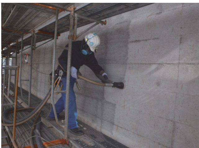
写真-1 施工状況
