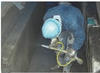
不陸調整-StoCrete TF204吹付
