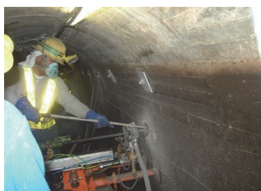
ロックボルト孔の清掃
