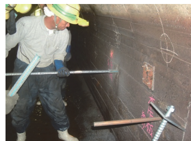
ロックボルトの打設
