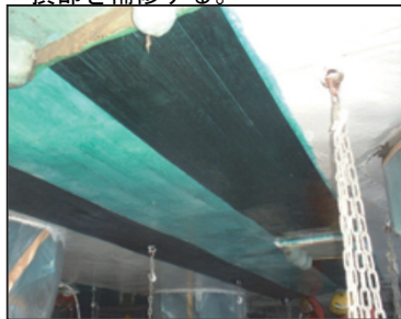
⑤炭素繊維シート接着 炭素繊維シートを必要な層数接着する。
