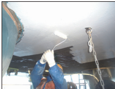
④緩衝材塗布 ローラーなどを用いて緩衝材を塗布する。
