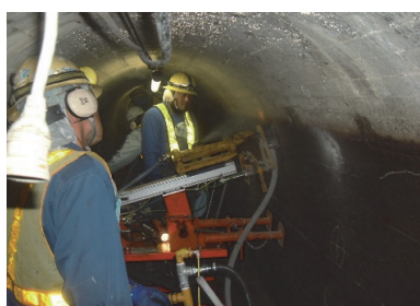
ロックボルト孔の削孔
