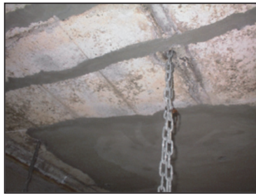
②下地処理 コンクリートのひび割れや欠損部を補修する。
