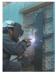
Tプレート挿入
