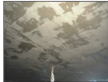
③プライマー塗布・不陸修正 プライマー塗布後、パテ等で不陸を修正する。
