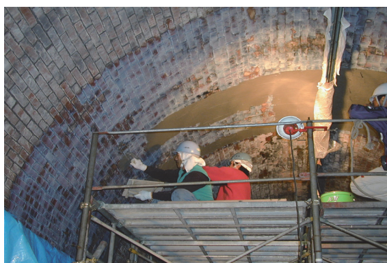
レンガ積トンネルの施工状況図
