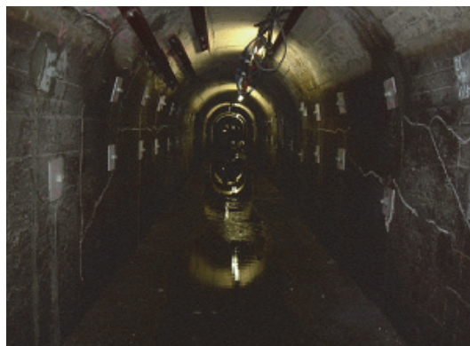
ロックボルトで補修された坑内
