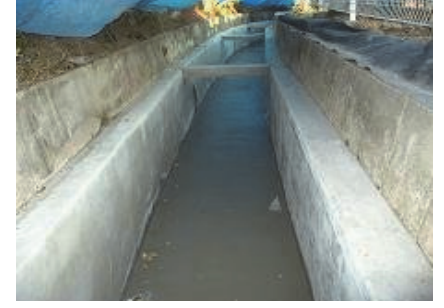
不陸調整-StoCrete TF204完了
