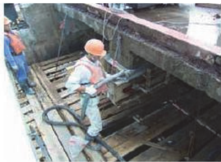
打設状況写真
