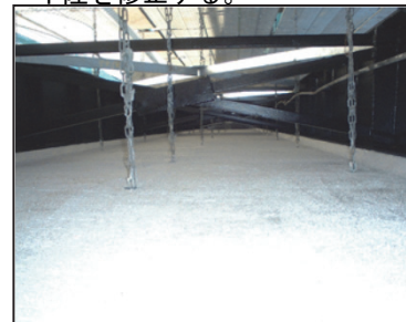
⑥表面仕上げ 美観や表面保護のために表面塗装を行う。
