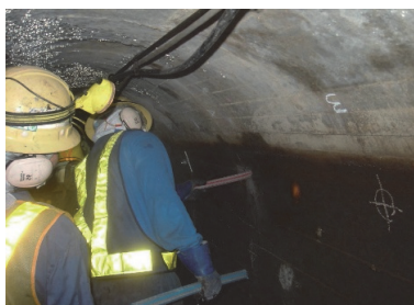
セメントカプセルの挿入
