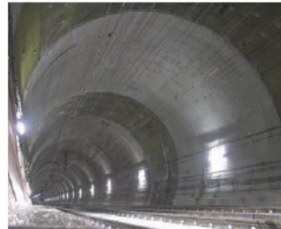
施工例 2 トンネル覆工コンクリート補強
