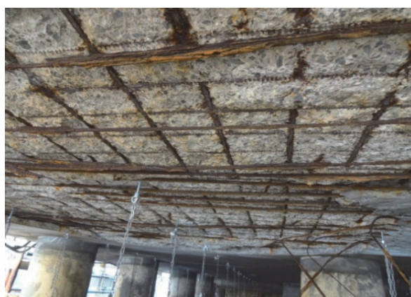
栈橋塩害劣化状況
