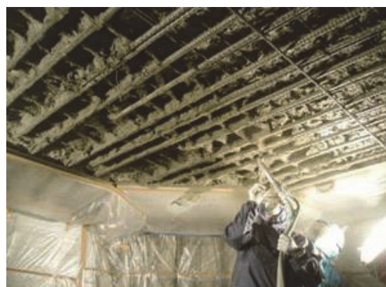
高架橋他修繕工事スラブ下面補修状況
