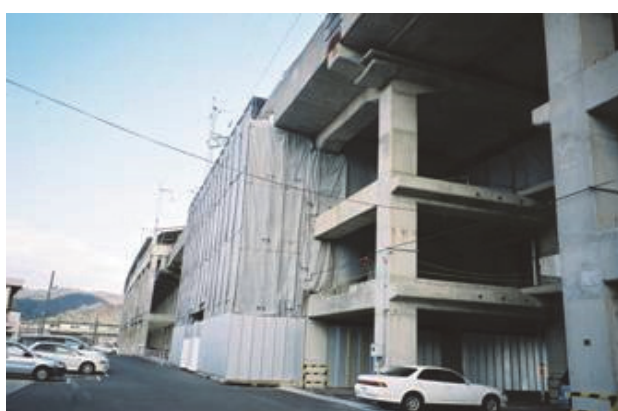
高架橋他修繕工事スラブ下面補修状況
