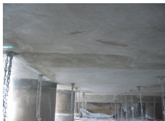
ジョツククリート断面修復完了
