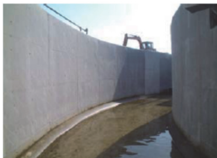
施工例 1 既存劣化水路改修
