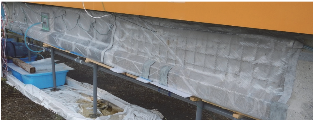
塩害劣化により撤去されたPC桁に対する本技術(脱塩工法)の適用状況
