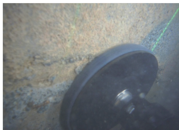
図2 検査面清掃・ケレン状況
