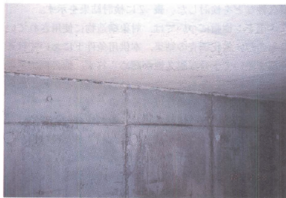
写真-1 壁部補修後のブロー槽壁部の状況(天井部は未補修)
