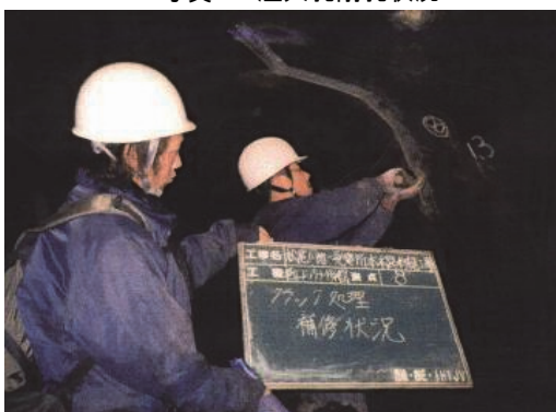
写真-3 クラック補修状況
