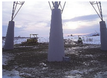
完成 (クラック架橋・追従性表面保護RB)
