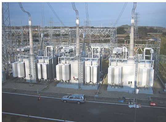
ひび割れ補修後表面保護コーティング完了全景
