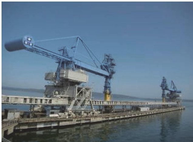
揚炭棧橋 全景
