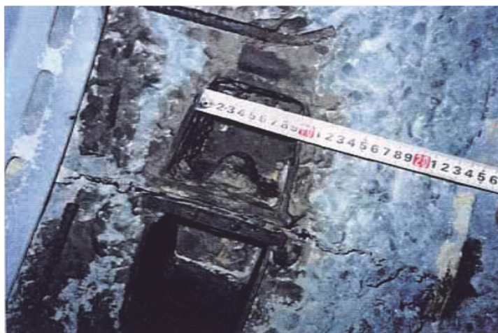
図-2 腐食したボルトボックス
