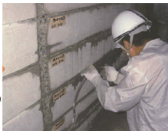
施工状況写真
