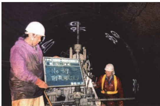
写真-1 注入孔削孔状況
