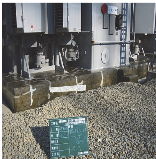
ひび割れ注入及び含浸材塗布
