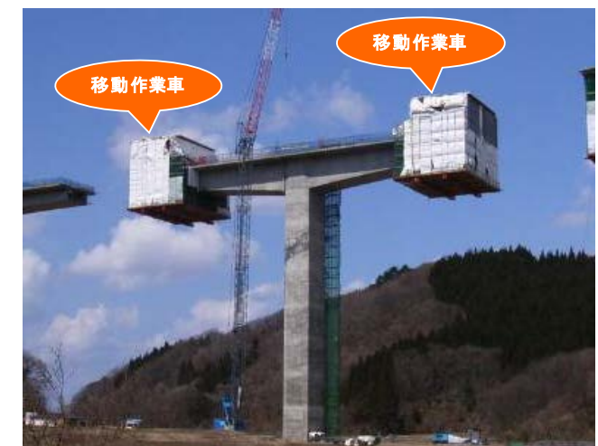
図-2 片持ち架設工法の施工例
