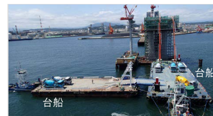
台船でコンクリートを運搬し、P7橋脚の桁に打ち込んでいる状況（台船上にポンプ車、生コン車を配置）
