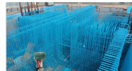
青いエポキシ樹脂塗装が施された鉄筋を組み上げた状況（柱頭部の横桁鉄筋）
