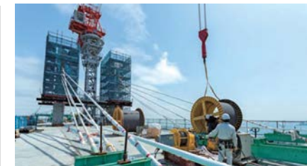
景観に配慮して採用された白色のケーブルを傷つけないように架設している状況
