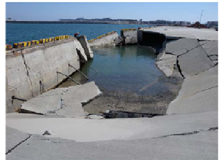
図 2.32 矢板式岸壁被災例 25)
