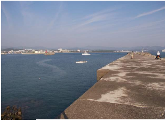
写真 6.5 沖防波堤(西側)
