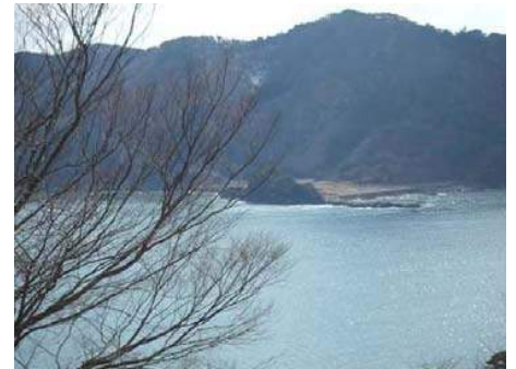
図 2.6 大船渡湾口防波堤の被災状況 6)
