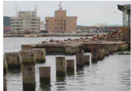
図 2.33 栈橋式岸壁被災例 26)
