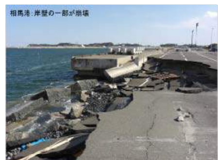
図 2.31 ブロック積式岸壁被災例 12)
