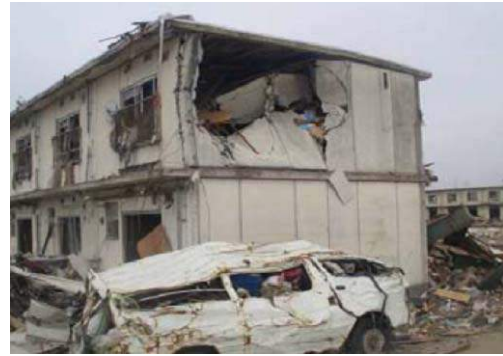
図 4.2 漂流物衝突による外壁の破壊 3)
