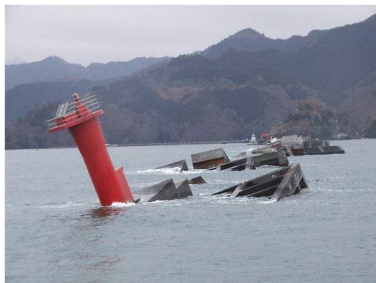
図 2.41 ケーソンの被災状況 5)
