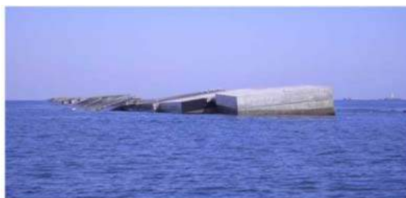
図 2. 27 沖防波堤の被災状況 24)
