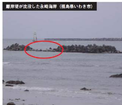
図 2.34 離岸堤被災状況 27)
