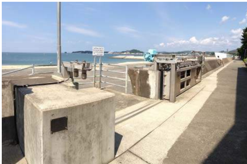
写真 6.9 防潮堤に設置された陸閘
