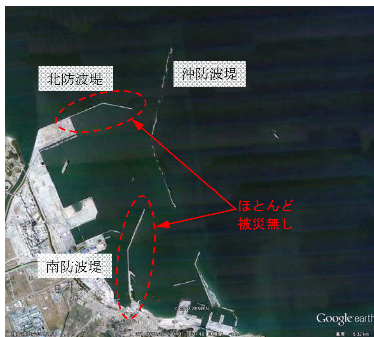
図 2.45 相馬港防波堤全景 12)
