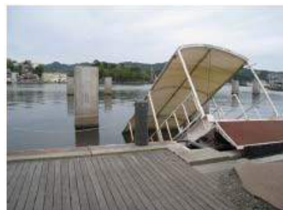
図 2.36 浮体被災状況 26)
