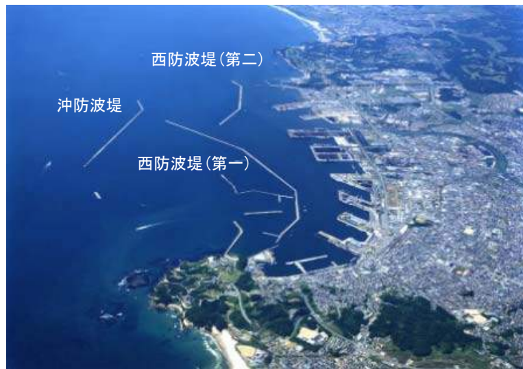
図 2.47 小名浜港 沖防波堤全景 36)
