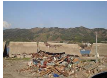
図 2.13 護岸の移動・傾斜被災例 10)
