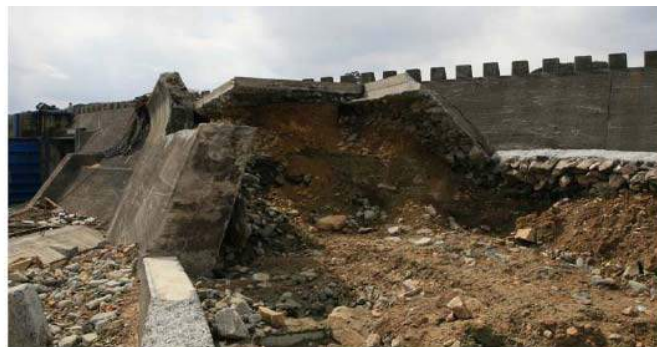
図 2.9 第2防潮堤の被災状況(左側が海) 9)
