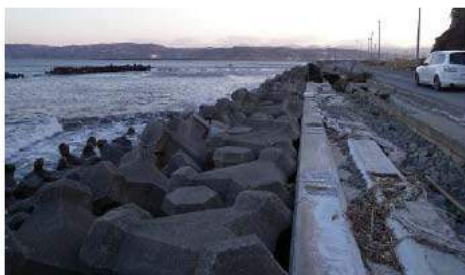
図 2.50 半崎地区の離岸堤(震災後) 25)
