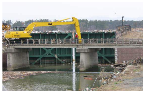
図 2.23 野蒜水門背後に堆積した瓦礫
