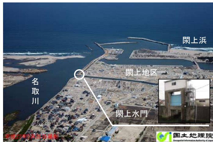
図 2.20 関上地区周辺の航空写真 16)
