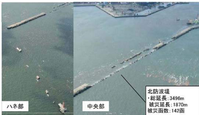
図 2.25 北防波堤の被災状況 21)
