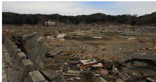
図 2.10 第2防潮堤の被災状況(右側が海) 9)
