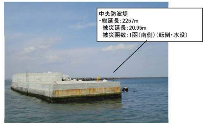
図 2.26 中央防波堤の被災状況 21)
