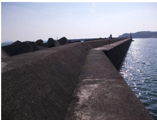
写真 6.3 沖防波堤(東側)
