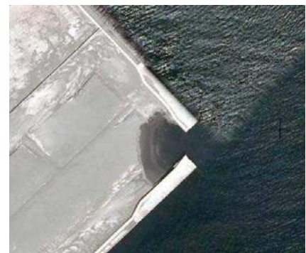
図 2.30 ケーソン岸壁被災例 16)
