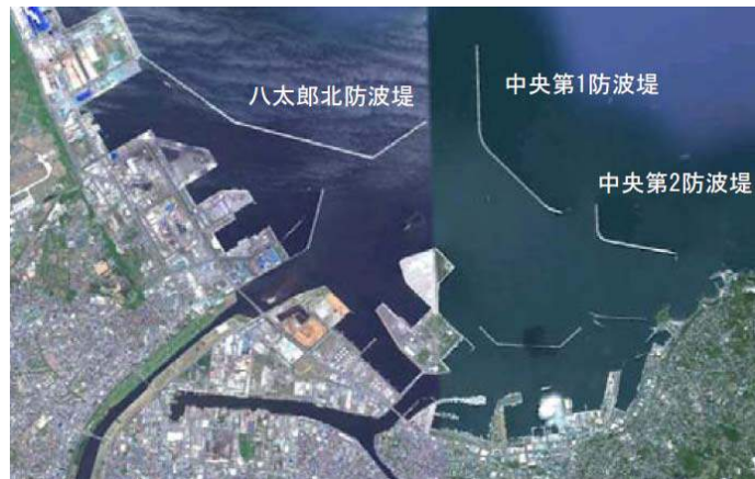
図 3.14 八戸港の防波堤整備状況(震災前) 16)
