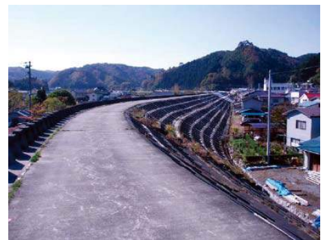
図 2.7 被災前の防潮堤 7)
