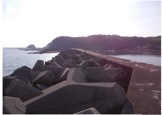
写真 6.6 沖防波堤(東側)
