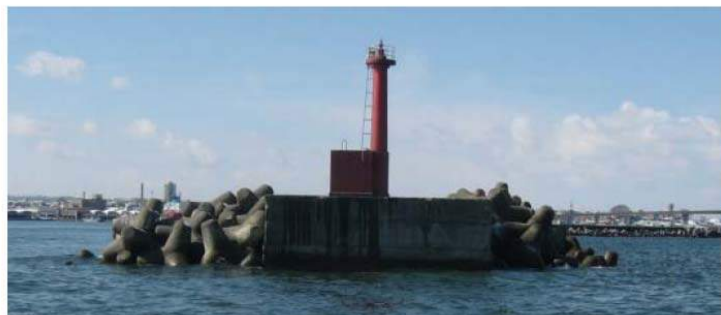
図 3.16 八太郎北防波堤の堤頭函周囲の被災状況 16)
