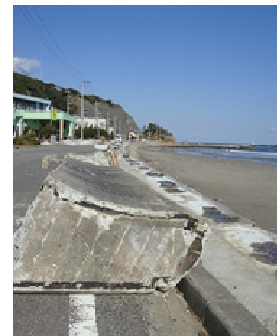
図 2.14 パラペットの被災例 11)
