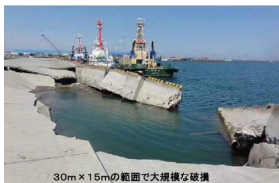
図 5.26 相馬港の1号埠頭の被害状況 (矢板継手・タイロッド破損、エプロン陥没等)
