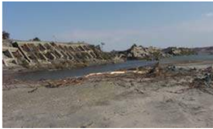
図 2.15 堤防の被災例 12)
