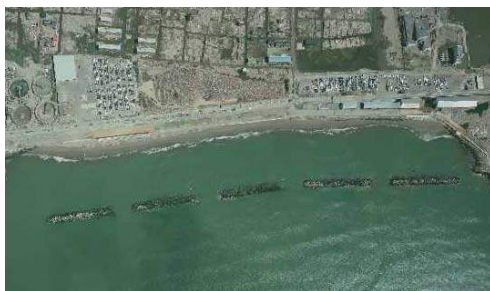
図 2.48 石巻港 港外北部の離岸堤(震災後) 12)
