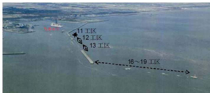
図 3.15 八太郎北防波堤被災状況 16)
