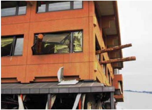
図 4.1 開口部からの木材の流入 3)
