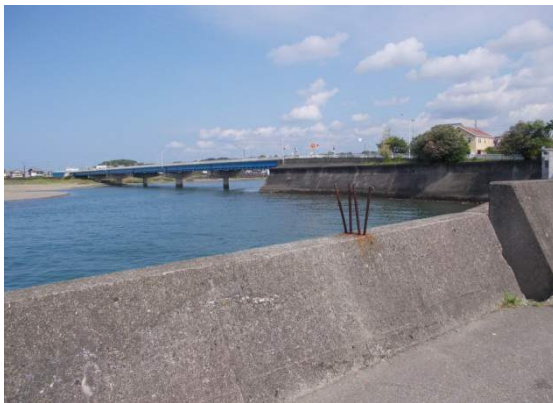
写真 6.7 A 漁港周辺の防潮堤
