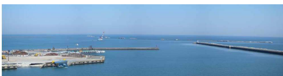
図 2.46 相馬港 沖防波堤の被災状況 25)
