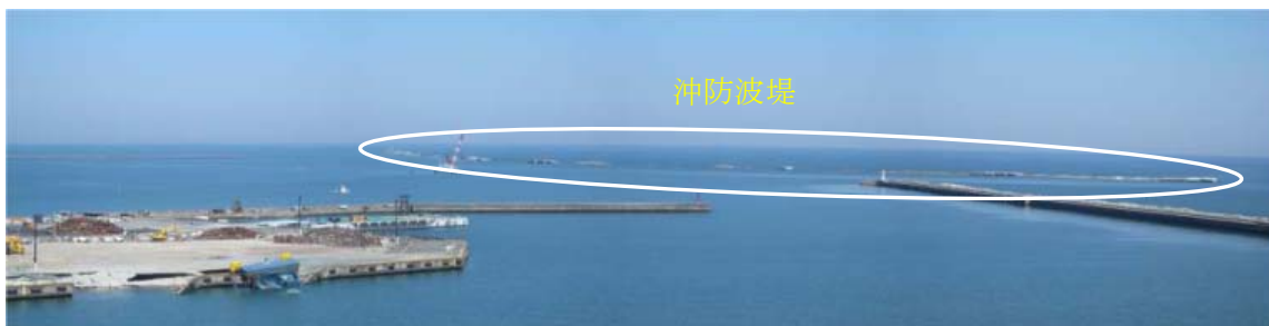
図 2. 26 被災後の相馬港全景（奥にあるのが沖防波堤） 23)
