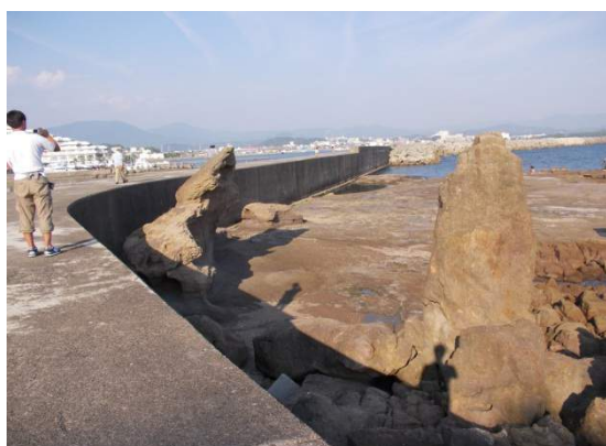
写真 6.4 沖防波堤(西側)
