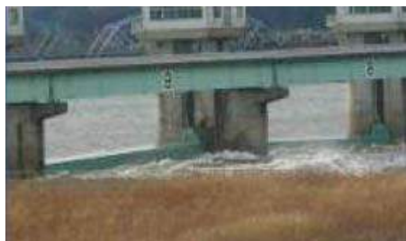
図 2.18 浮き上がっている扉体の様子
