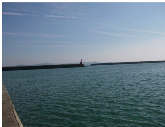
写真 6.2 泊地から沖防波堤を望む
