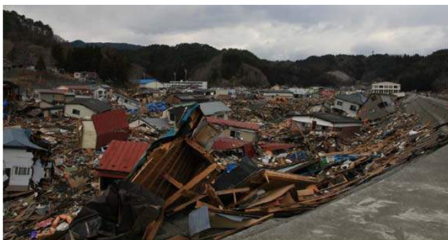
図 2.11 第1防潮堤内地の被災状況 9)
