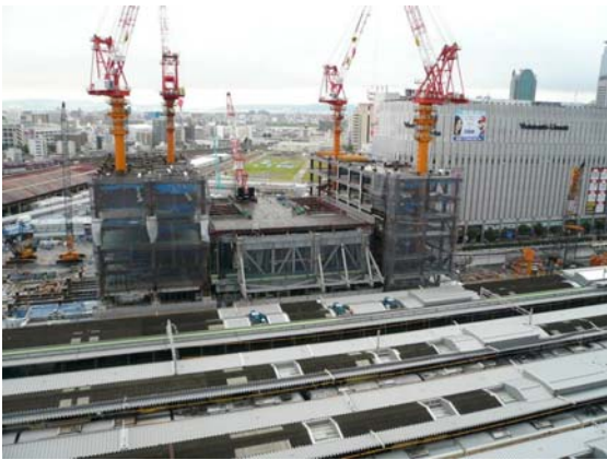
写真-4 橋上駅鉄骨地組完了状況
