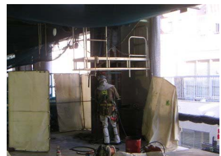
写真-12 鉄骨溶接火花養生
