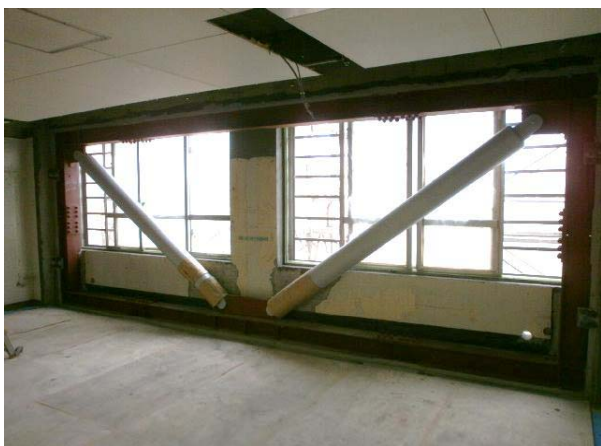
写真2 耐震鉄骨プレス
