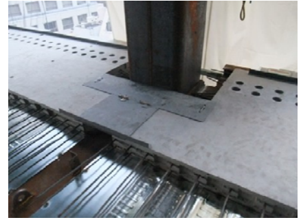
写真-7 脱着式仮設鉄板
