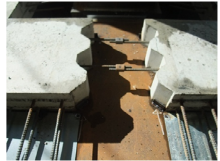
写真-10 PCa板仮固定
