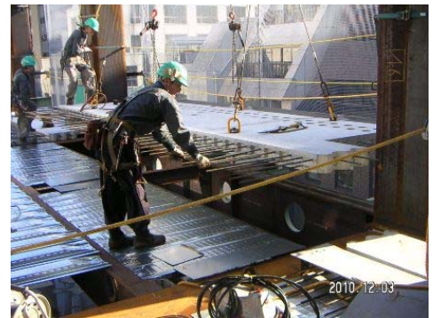
写真-6 取付状況
