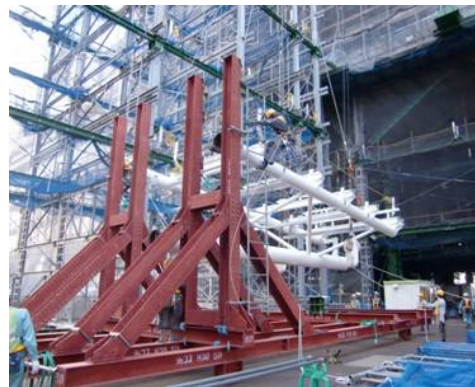
写真-11 トラス移動台車
