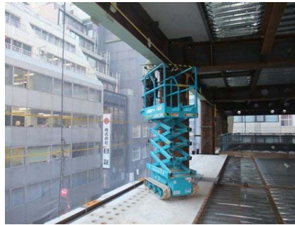
写真-9 本締め状況
