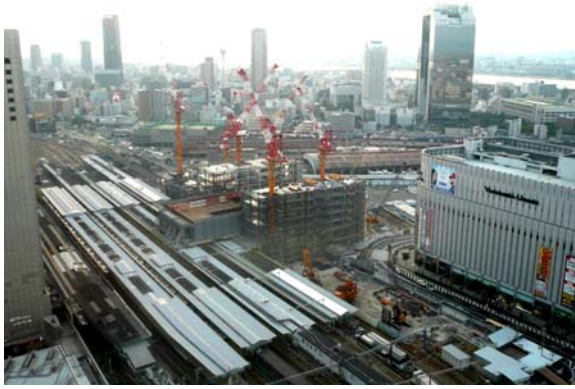
写真-1 橋上駅工事施工状況
