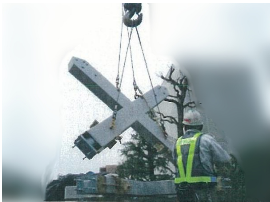
写真3 建起こし状況
