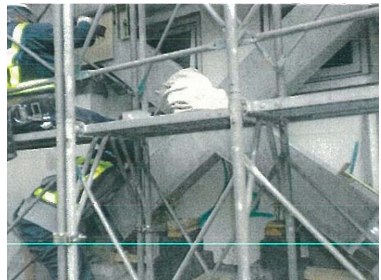
写真6 四隅型枠状況
