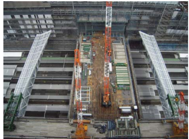
写真-9 東西架構建方用トラベラークレーン設置状況
