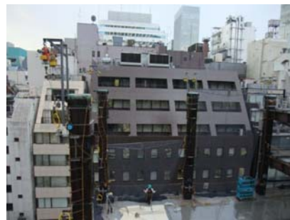
写真-3 垂直ネット吊り上げ
