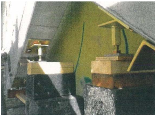
写真5 下部仮設支持部状況
