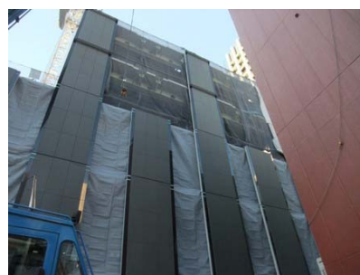
写真-11 外装PCa先行取付
