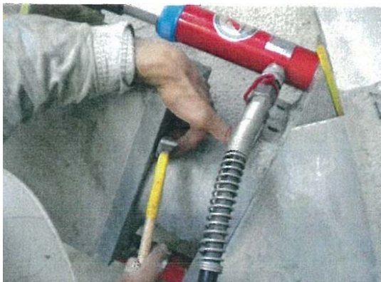
写真7 くさびによる鋼管止め状況
