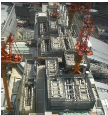
写真-10 地組ヤード全景
