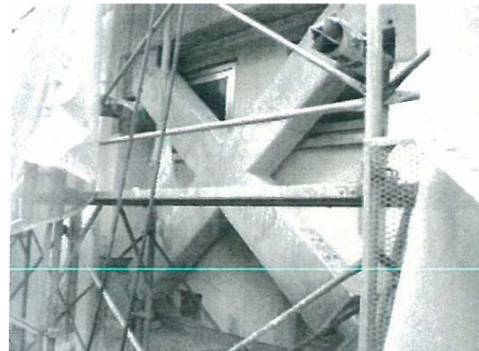
写真8 取り付け完了状況
