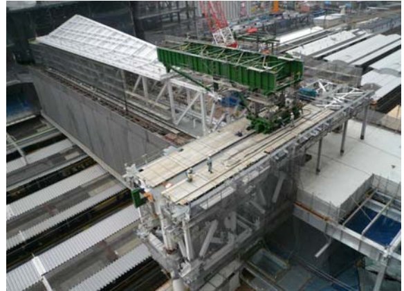
写真-5 南北架構スライド開始前の状況
