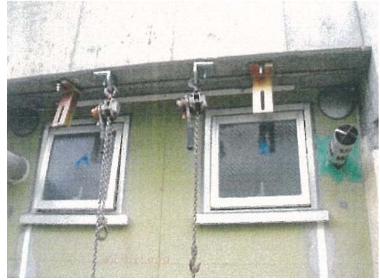
写真4 上部仮設金物状況
