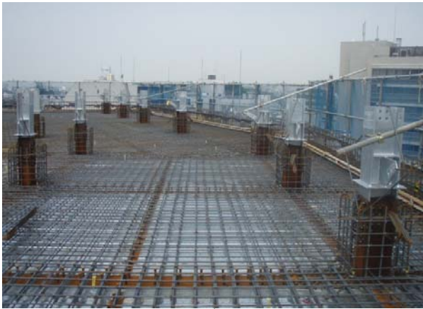
写真-2 R階スラブ配筋補強状況
