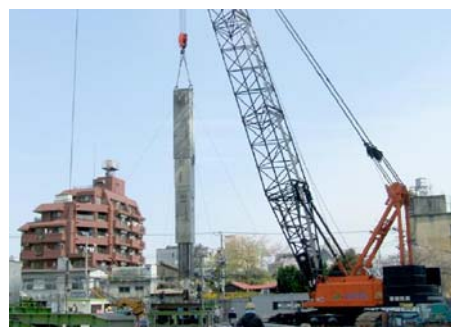
写真-5 PCa 構真柱建込み状況
