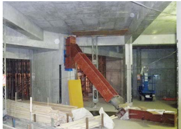
写真-6 仮設鋼材によるRC柱補強
