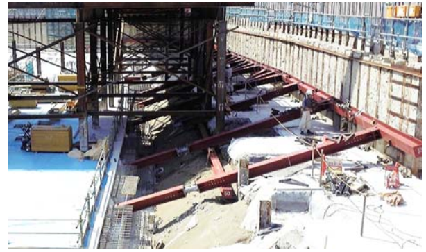
写真-7 マットスラブに取付けた切梁
