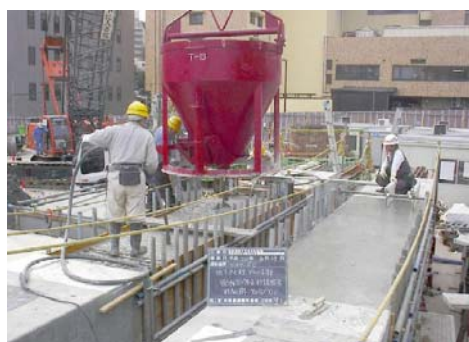
写真－2 現場ジョイント部コンクリート打設状況
