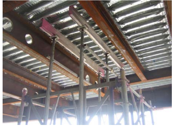
写真-3 支保工状況(デッキリブ 隙間は木製キャパ-で対応)
