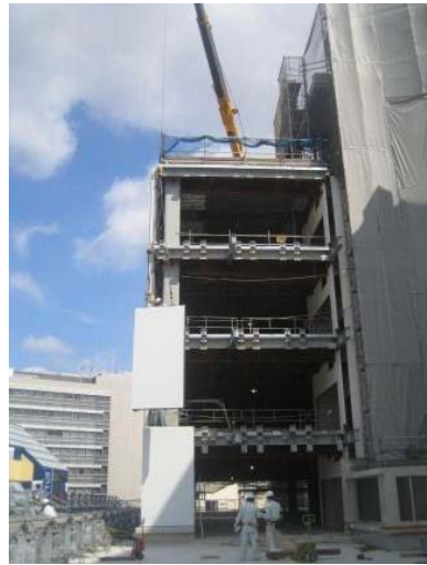
写真-9 R F屋上にて高層PCa取付状況
