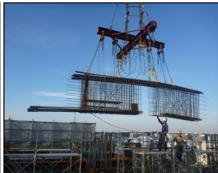
写真-6 地組梁吊込
