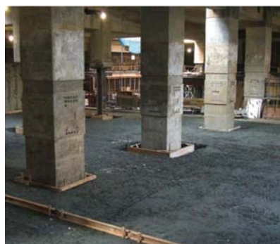
写真-6 二次掘削状況
