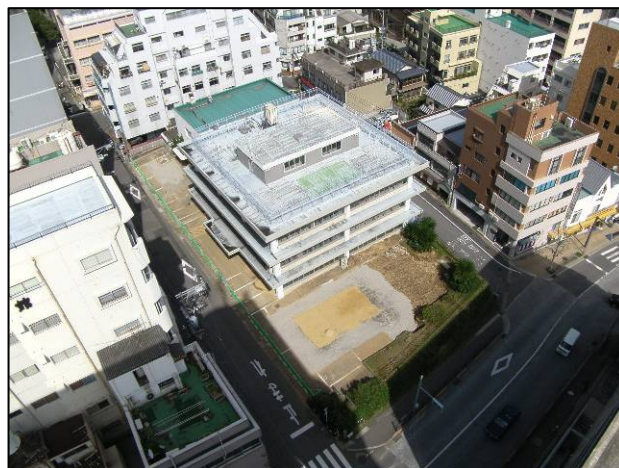
写真-2 着工前全景
