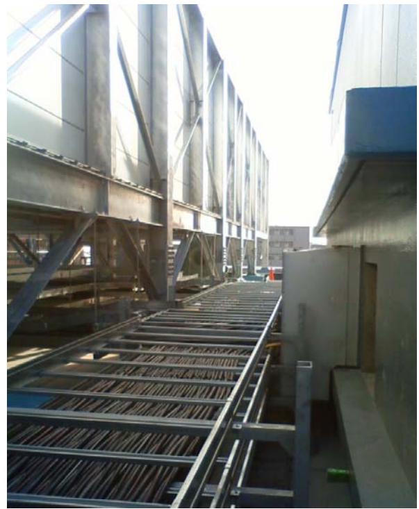
写真-11 設備架台組立完了
