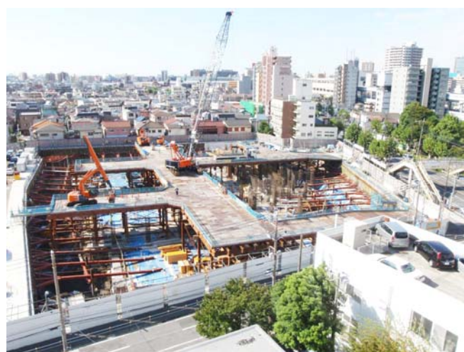
写真-1 アイランド施工中、全景
