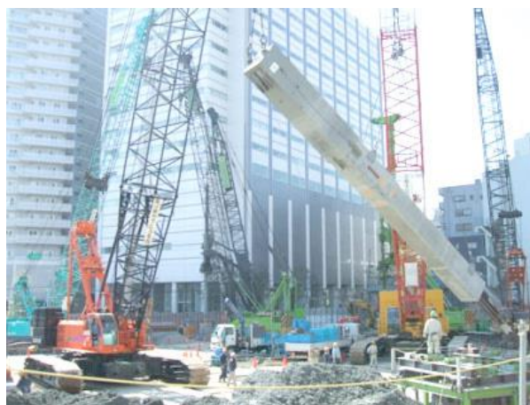
写真-1 PCa 構真柱施工状況
