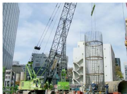
写真-4 杭かご筋建込み状況
