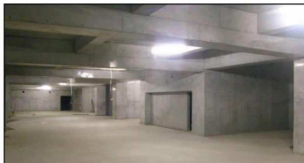
写真-5 地下1階 駐車場
