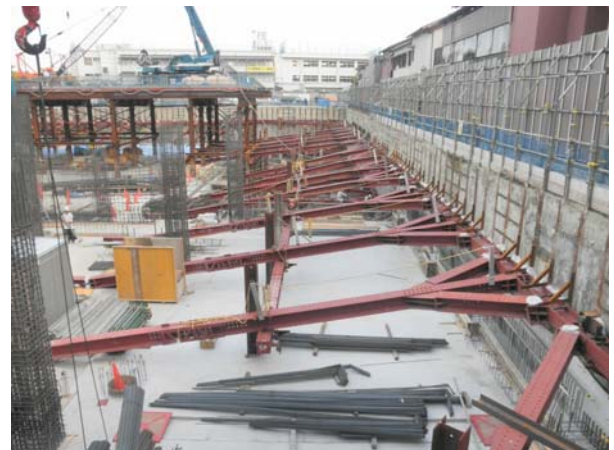
写真-5 斜め切梁と火打ち
