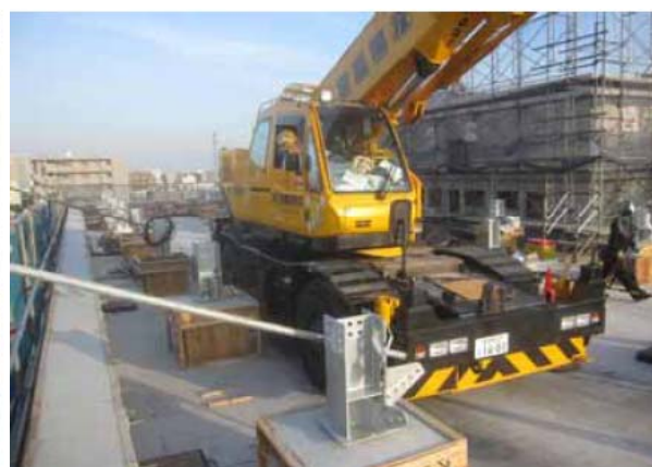
写真-8 8F屋上
