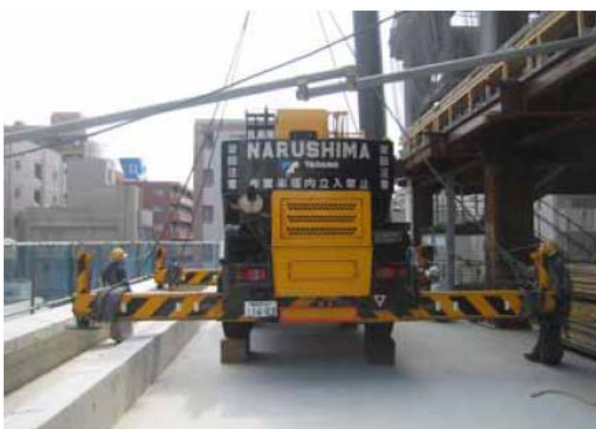
写真-7 5Fクレーン設置
