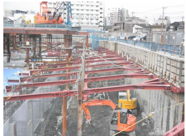
写真-8 外周部後攻躯体、掘削状況
