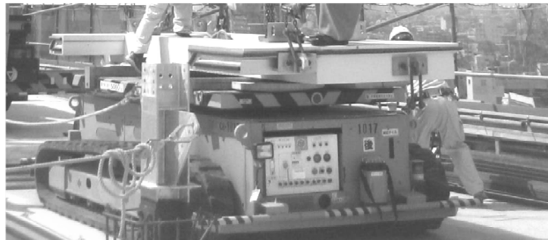
写真-5 重量物運搬車設置
