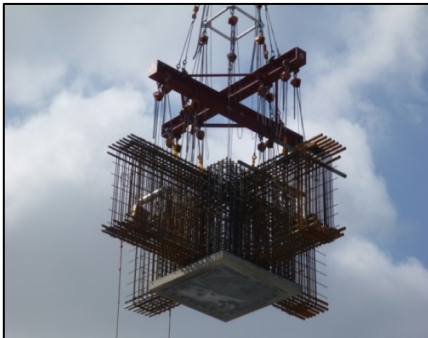
写真-5 地組梁吊込(免震プレート付)
