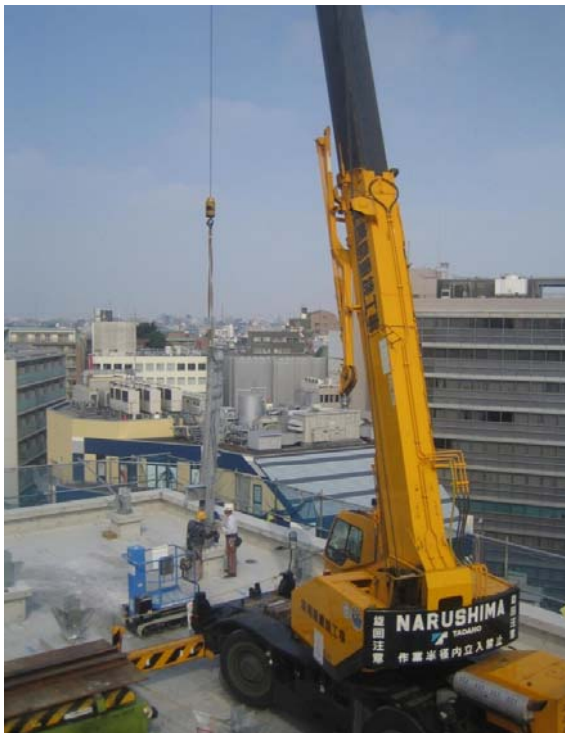
写真-10 屋上鉄骨建方状況
