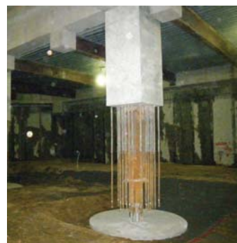
写真-7 三次掘削状況
