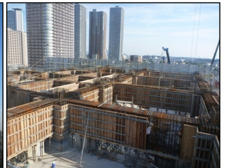
写真-7 免震上部基礎梁型枠組立
