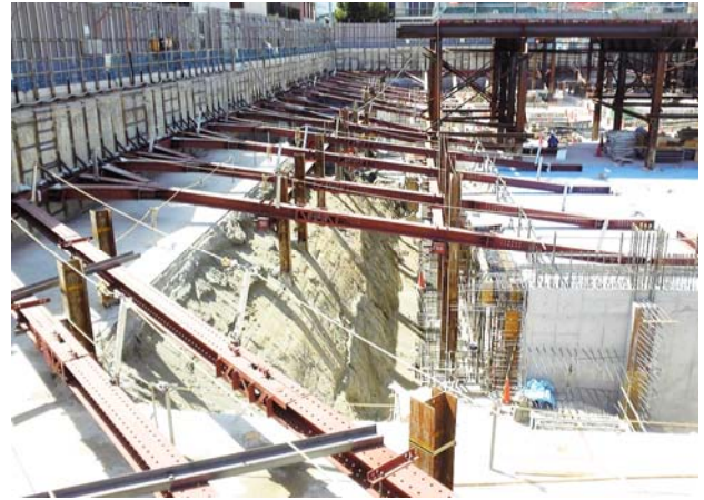
写真-3 切梁架設と法面
