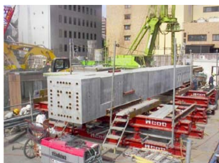
写真－3 PCa 構真柱現場地組み状況
