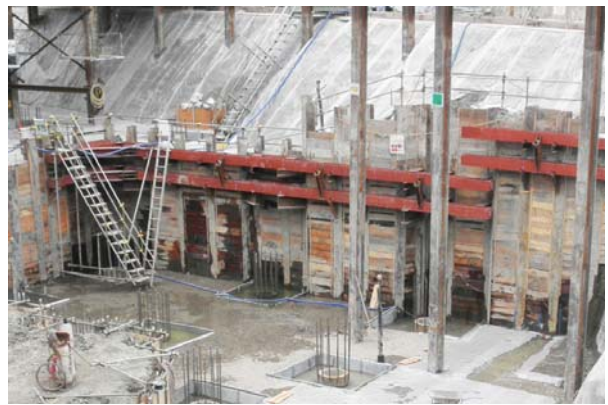
写真-4 仮設地盤アンカー部腹起し
