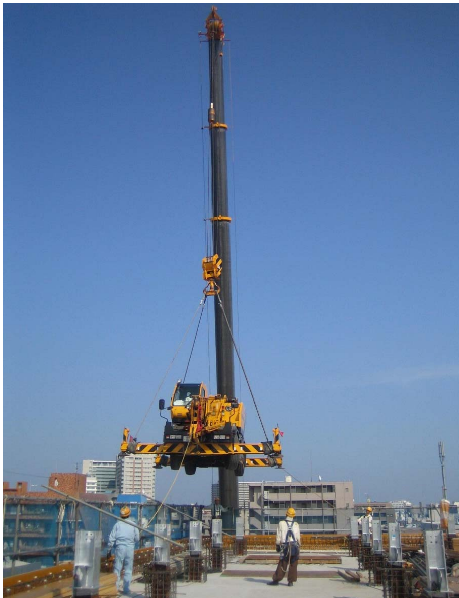
写真-6 16t移動式クレーン揚重
