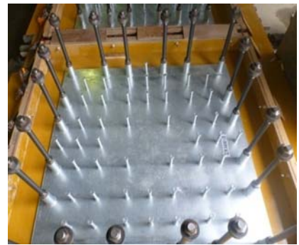
写真-2 免震上部プレートPCa化(配筋前)
