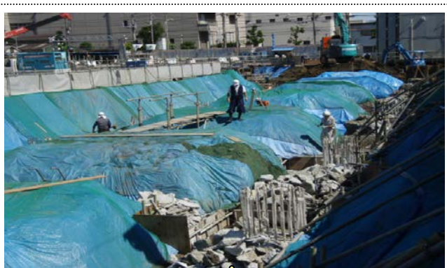
杭頭処理したコンクリート塊
