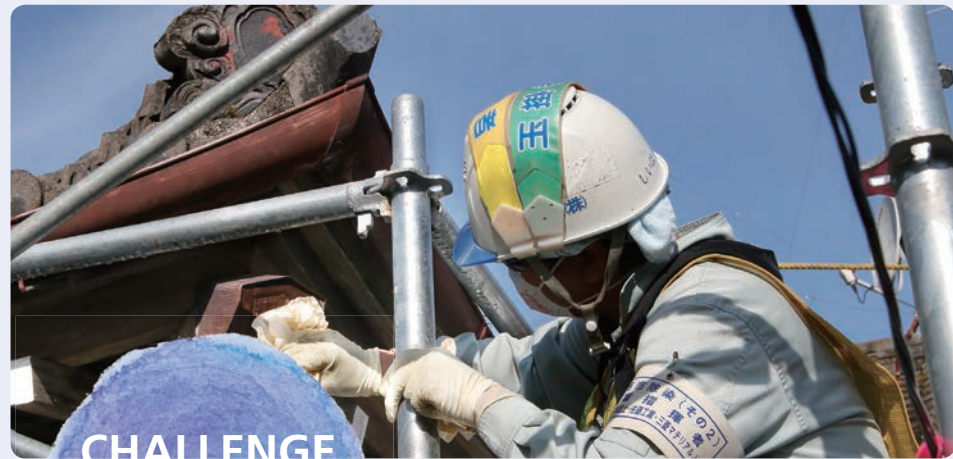
住宅の屋根の除染
