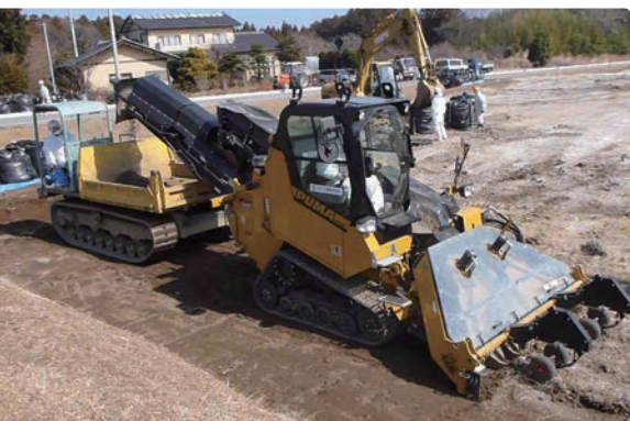
農地表土の鋤取り（スキマー工法）
