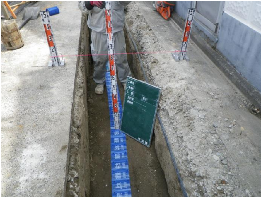
明示シートの設置の例
