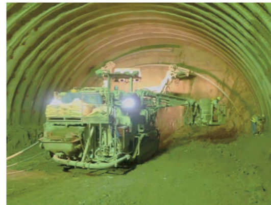
写真-2 トンネル掘削状況
