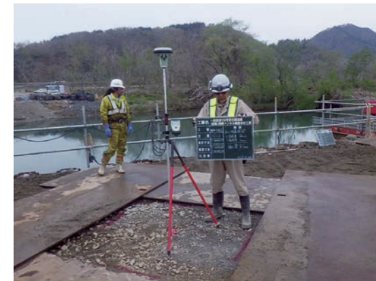
写真-3 橋梁下部 杭芯出し作業状況
