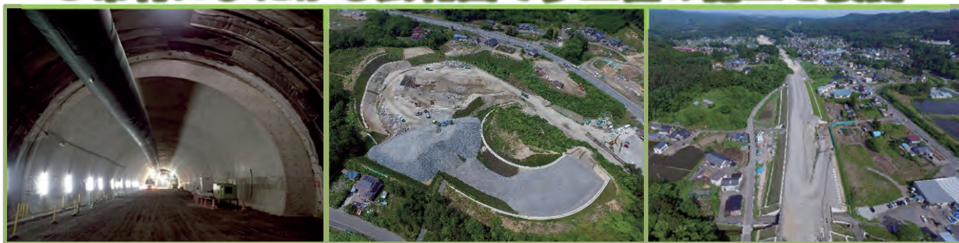
白井地区道路工事の各エリア現況（平成30年6月撮影）
