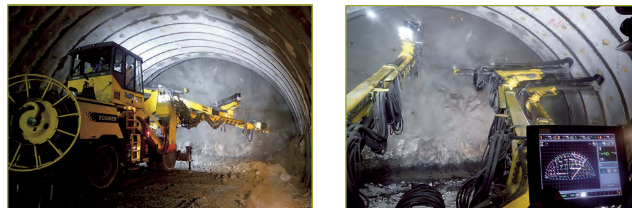
4ブームフルオートジャンボでの施工
