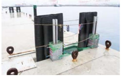
▲ケーソンとケーソンの間の鉛直遮水工では、特殊ゴムと遮水材で遮水を行う。事前に試験施工などを行い、施工性や遮水性能などを確認した。
