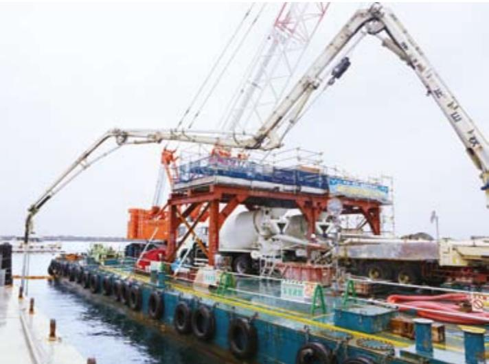
▶底面遮水工の水中不分離性コンクリートは陸上から生コンクリートをホッパーに入れて台船で運び、クレーン付台船に載せたミキサー車で混和剤を混ぜ、そこから海底に打設する。この現場、オリジナルの施工方法だ。
