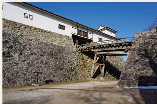
彦根城・天秤櫓下の石垣。奥側の石垣は築城当時の「野面積み」のままだが、手前側は幕末期に石の角部を下にして積み「谷積み(落とし積み)」で積み直されている。(提供:三浦正幸教授)
