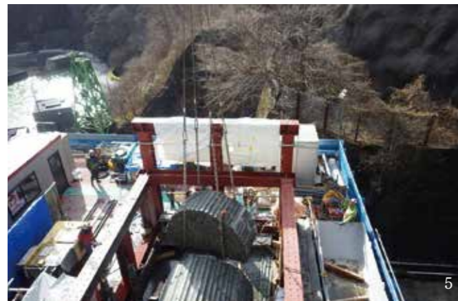
1. 堤体削孔施工状況全景 2. 上半部削孔状況(スリット作成) 3. スリット完了 4. 上半部割裂状況(パースター工法) 5. 上半ブロック切断・搬出状況 6. 堤体削孔完了(上流より)
