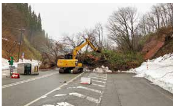
珠洲道路(穴水-珠洲間)の啓開作業 (提供:日建連会員企業)
