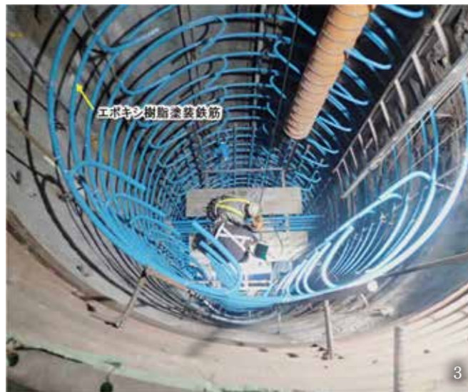
1. 天ヶ瀬ダム再開発事業全景 2. 減勢池側壁スライドフォームの設置 3. RC円柱支保工鉄筋組立状況 4. 放流エリア全景
