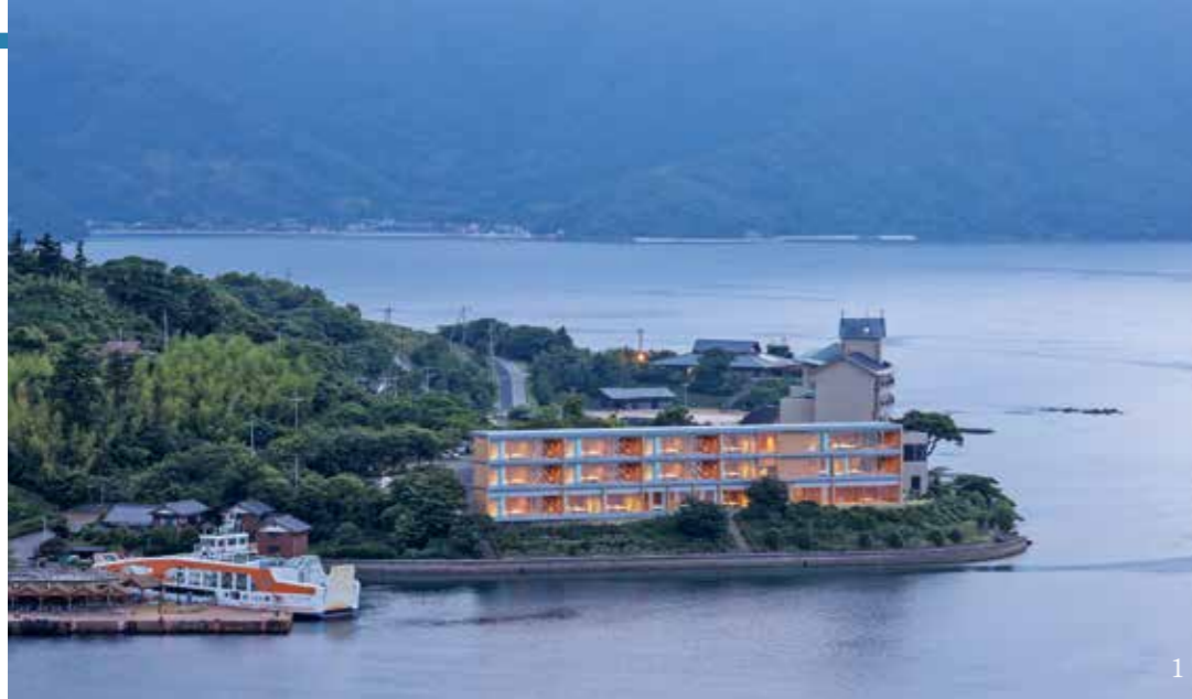
1. 海岸沿いに建つ宿泊施設 2. 北東側外観 3. エントランス
