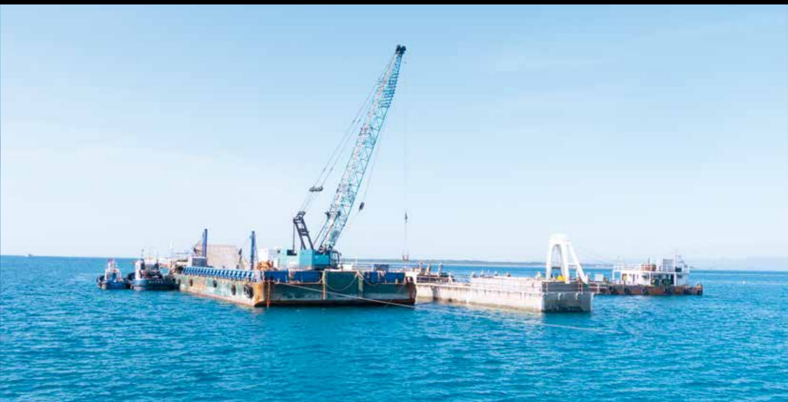
石垣港の沖で進む防波堤築造の現場。基礎捨石均し及び被覆石均しに水中バックホウが活躍している。水中バックホウは施工能力が高く、少ない潜水士と短い時間で施工が可能だ。
