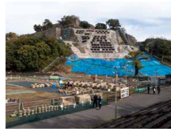
グラウンドアンカーは20mほど先の亀山の岩盤層に定着している。遺構が確認されるとこれを避けてアンカーの仕様や間隔を変更する。盛土も文化財だ。法面を雨水から保護する吹付モルタルの下には不織布を敷設し、旧盛土と分離している。
