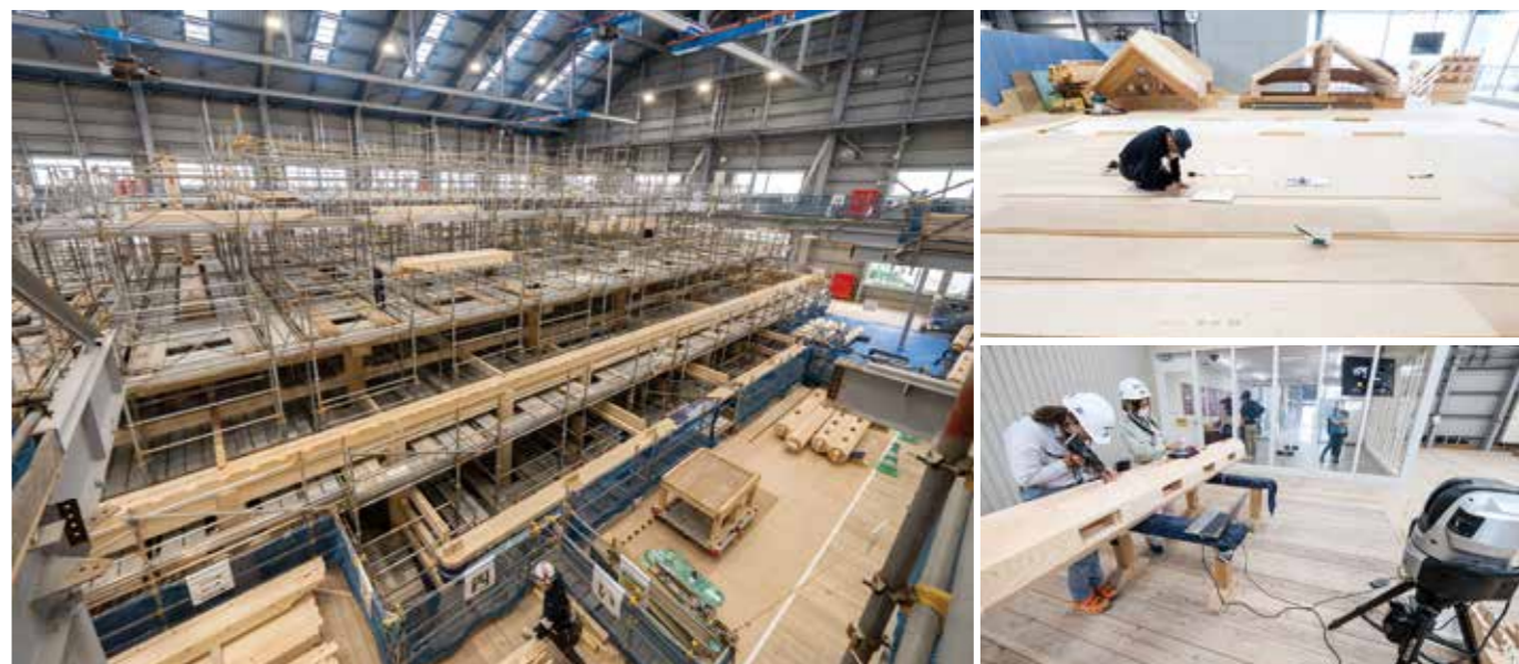
現場に沿うように見学通路が設けられた。「見せる復興の現場でコケる姿を見せるわけにはいかない」と川上所長は笑う。
