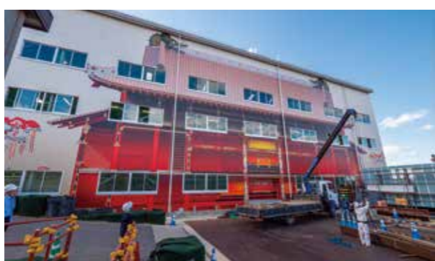
素屋根の壁面には復元後の首里城の姿が描かれ、見学者にそのイメージを印象付けている。
