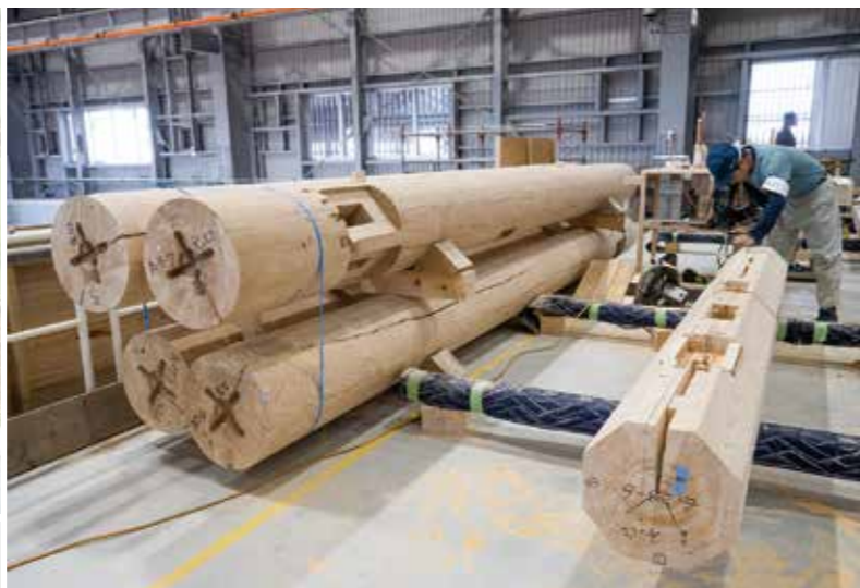
正殿に使われる木材は予備材も含めて534本。4本しかない貴重な長崎産のイヌマキは正殿正面の向拝柱に使われる。
