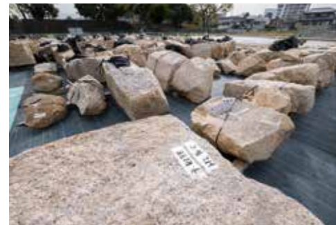
崩落した石材はプロフィールと「顔写真」と合わせて石材カルテに記録される。崩落石には「テ」の文字が記される。転石の「テ」だ。「テ」と書かれた石はその後の調査によって元の場所を突き止める。
