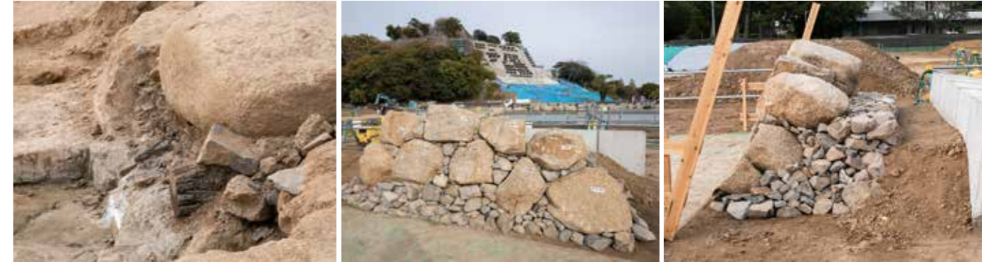
左／三の丸石垣を支える根石、胴木も検出。当時の土木技術を知る手がかりにもなる。中・右／今後着手される石の積上げに向けて試験施工を実施している。本来の盛土裏込め、石材のすべてが文化財だ。これらをどのように復元するのか詳細に検討する必要がある。裏込めは安山岩、盛土は主に花崗岩の風化土であることが判明している。
