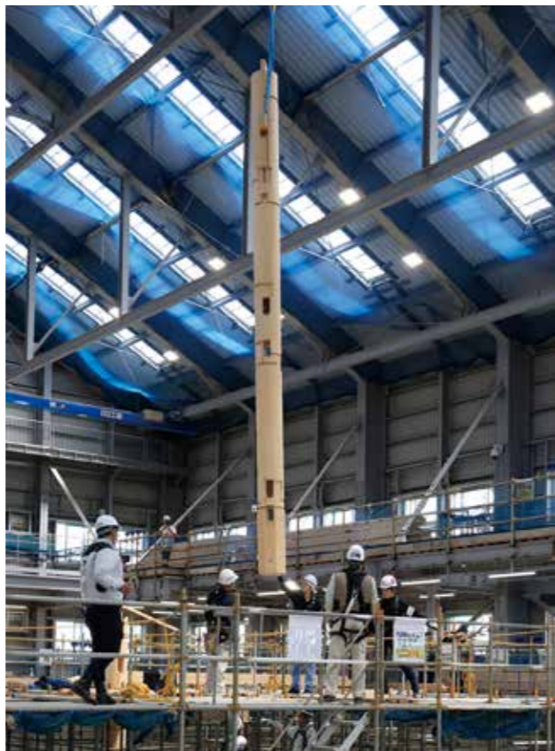
1本目の柱として直径約40cm、長さ約720cmの檜柱が建て込まれた。(提供：清水建設株)
