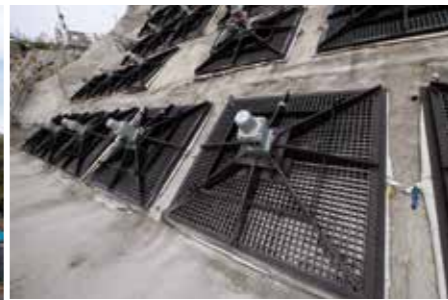
グラウンドアンカーは20mほど先の亀山の岩盤層に定着している。遺構が確認されるとこれを避けてアンカーの仕様や間隔を変更する。盛土も文化財だ。法面を雨水から保護する吹付モルタルの下には不織布を敷設し、旧盛土と分離している。
