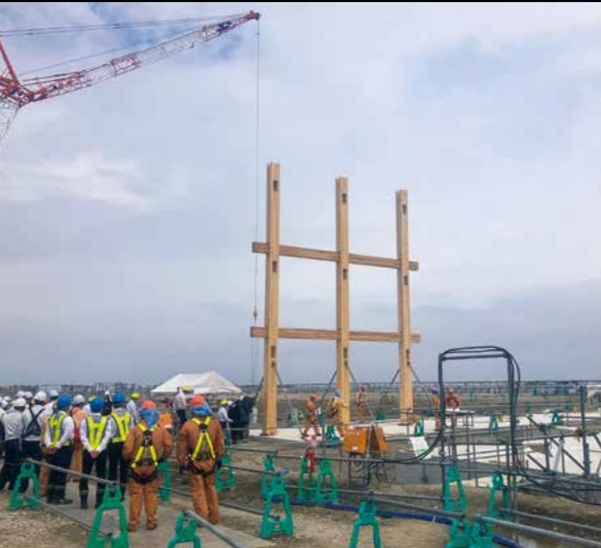
右/地上で柱材と梁を組み合わせたユニットをつくり、クレーンでつりあげて設置していく。写真は2023年6月30日に設置された最初のユニットの様子。（提供：株大林組） 左/会場を見渡しなが歩くことができるリング屋上の「スカイウォーク」。写真左手の斜面には植栽が施される。
