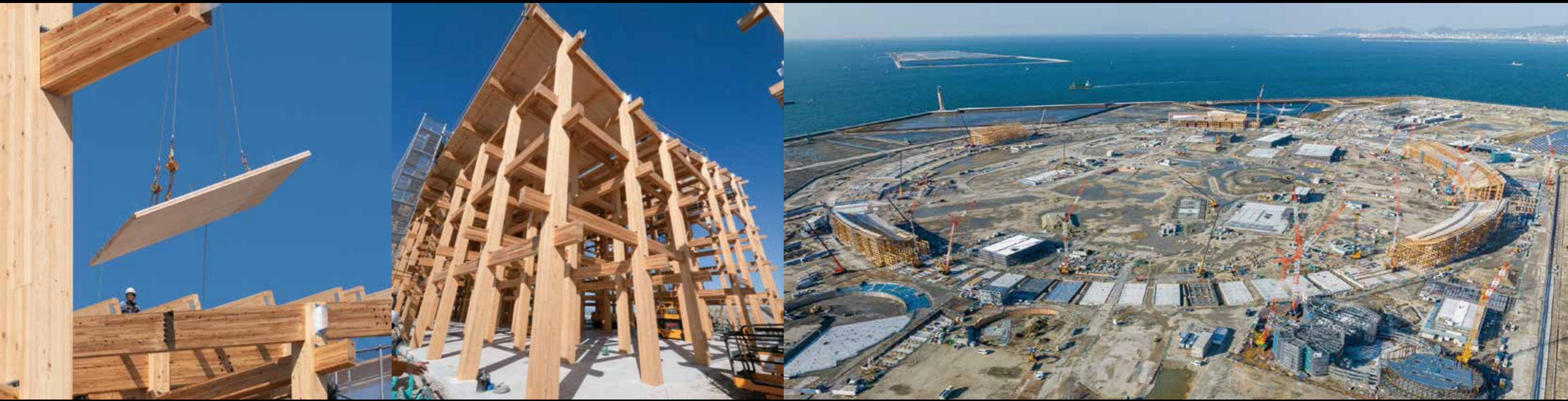
取材に訪れたのは昨年11月初旬。雲一つない澄み切った青空の下で木造リングの建設が着々と進んでいた。組み上げられた柱材と梁の上に床材が取り付けられていく。
