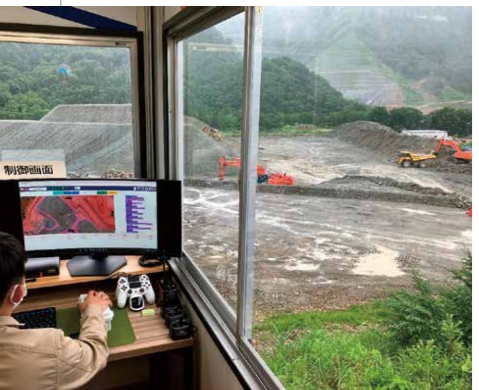
成瀬ダムにおける自動運転状況 (手にしているのが緊急停止ボタンで、右奥黄色のダンプトラックが自動運行中)
