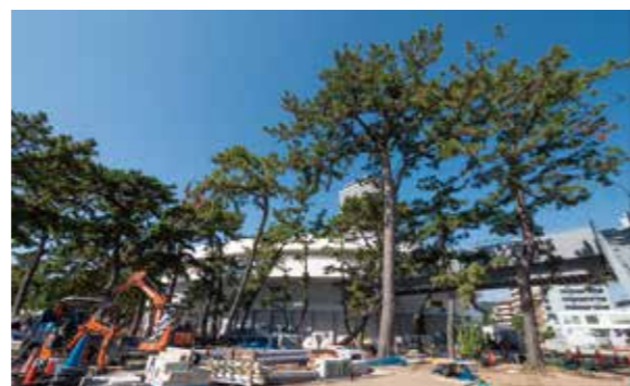
「海岸に沿って並ぶ松林の7割を保全することが条件でした。伐採することが許されているのはあと数本でした。建物のレイアウトも松林を避けながら検討した。枝が足場に当たったり、ギリギリの状態で重機を入れたり。工夫しながらの施工でした」（浜口氏）
