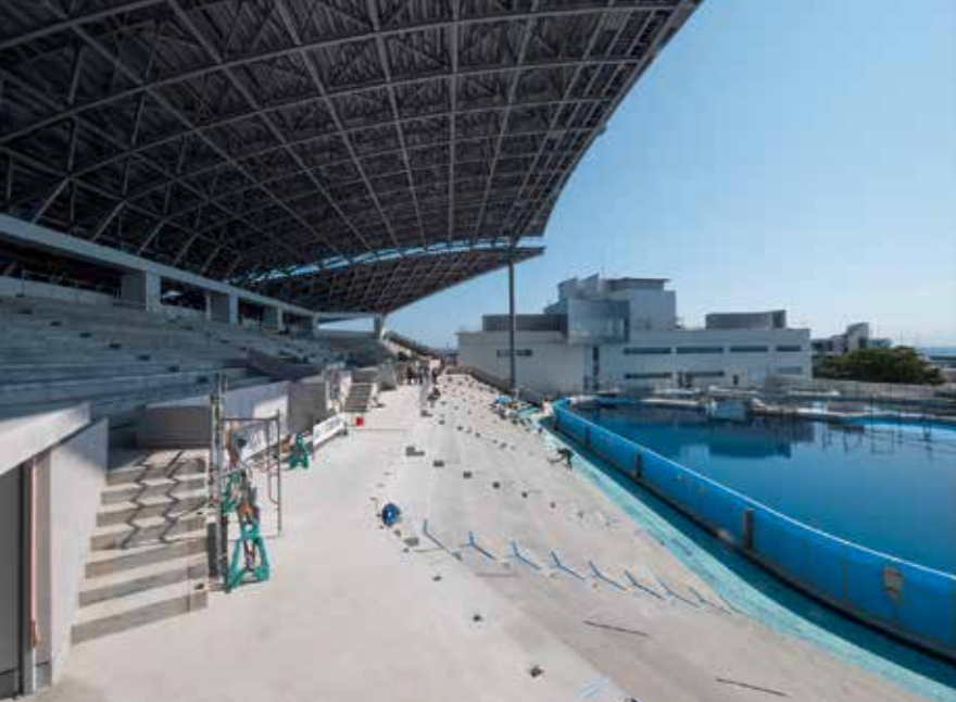
オルカスタジアム。シャチやイルカのパフォーマンスエリアはスタジアムの形状を採用し床部材はプレキャスト化した。
