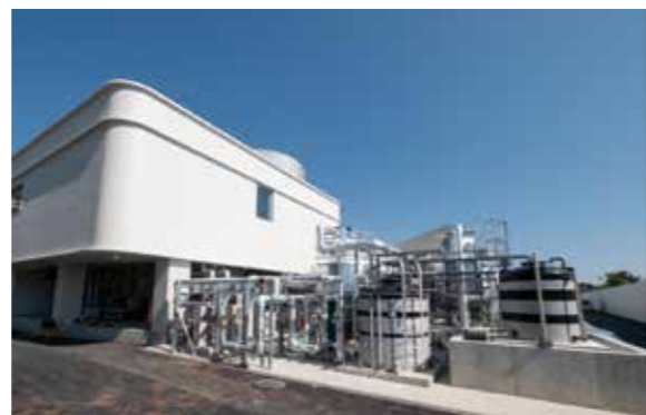
水槽の背後にはろ過器などの装置群を集約した。「工場を整備したような感覚。客席からは見えないレイアウトに腐心しました」（浜谷氏）
