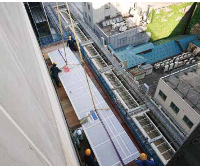
アクリルパネル搬入状況(写真提供:佐藤工業株)
