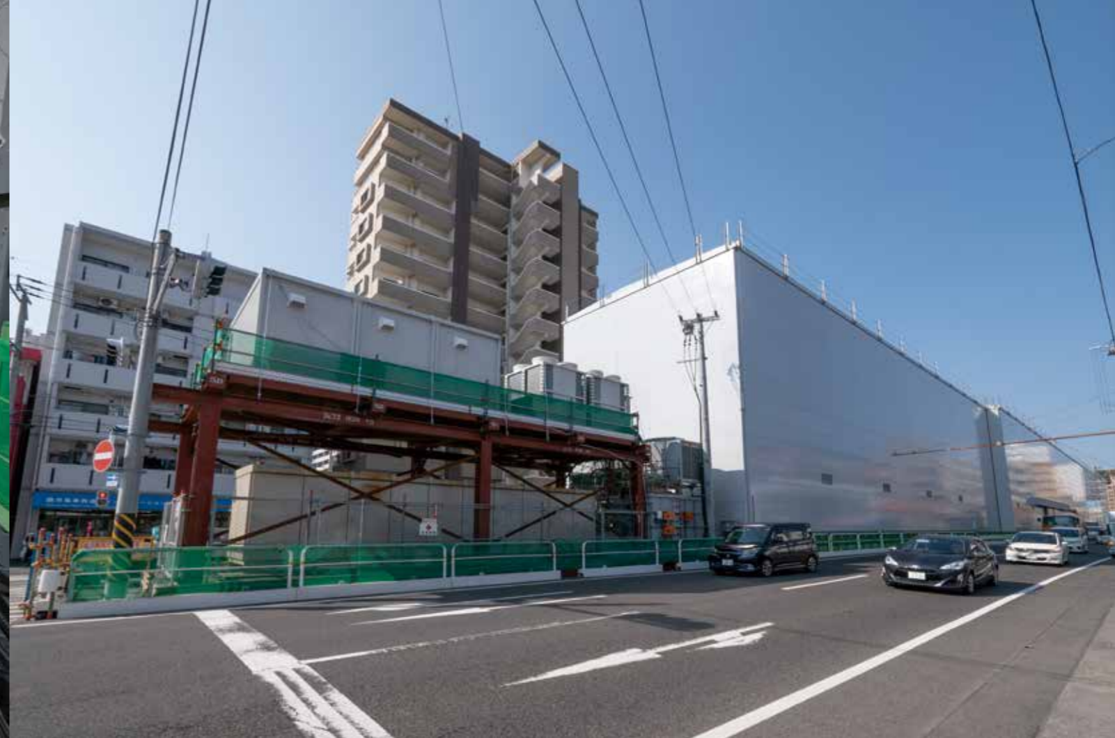
鹿児島市内を通る中洲通りの中央付近に建てられた防音ハウス。長さ約170m、高さ約14mで、立坑内で発生する騒音を閉じ込めている。
