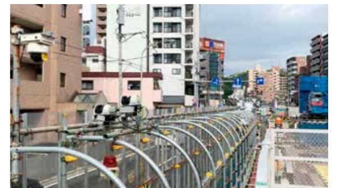
防音ハウス構築前、クレーンなどが一般道側にはみ出すことを防止するために導入したレーザーバリア。(画像提供：大成建設株)
