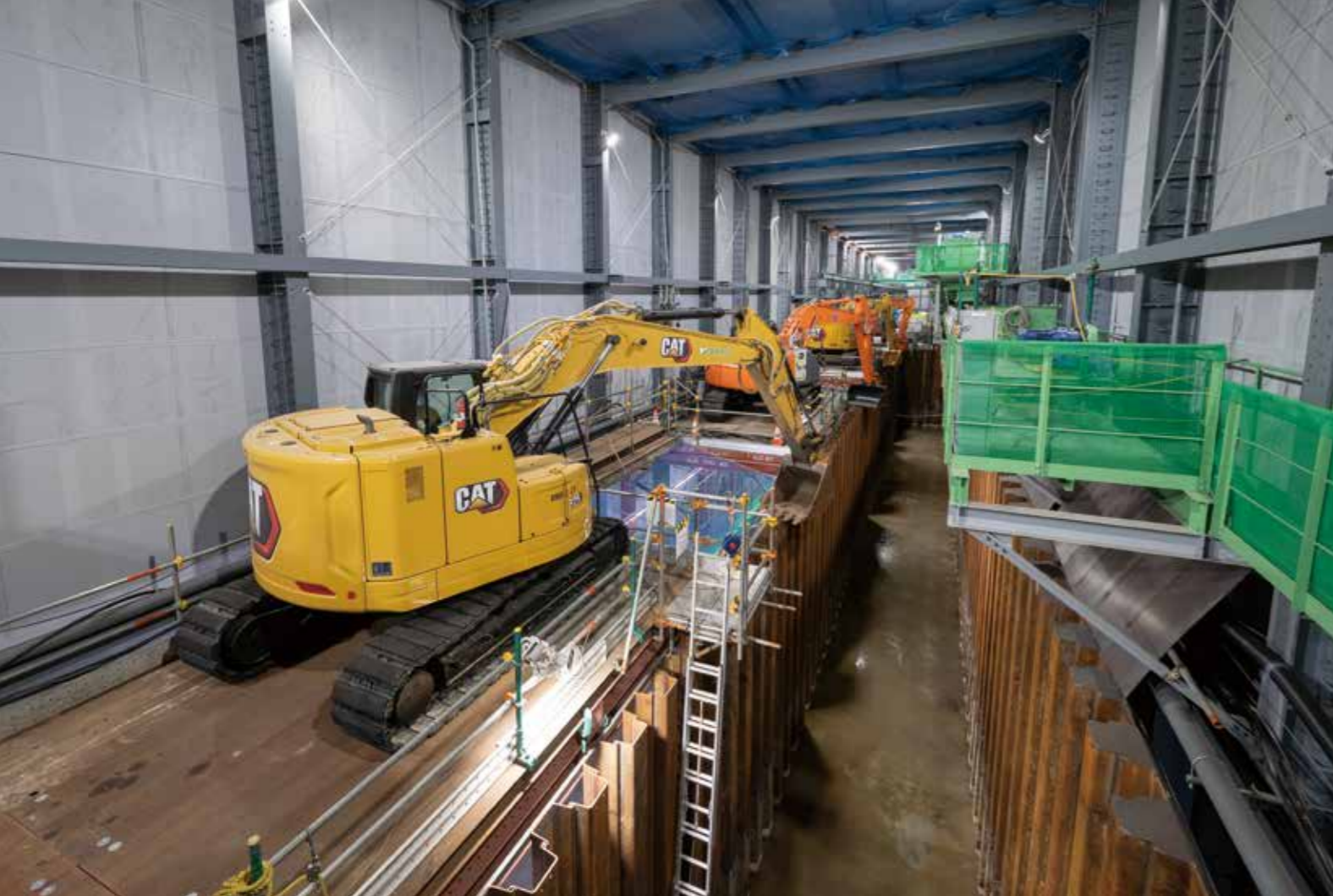
シールド掘進で発生した掘削土は、写真右側のベルトコンベアで運んで下部のピットに落とし込み、それを左の重機でダンブトラックに載せて搬出する。
