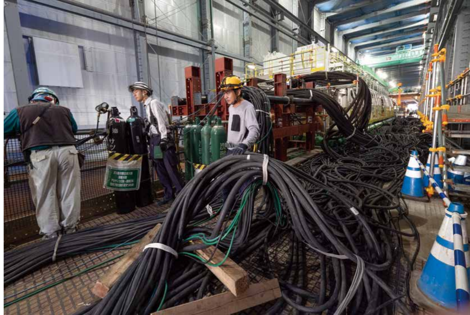
シールドマシンを動かすための無数のケーブル類。これらを配線し、掘進に従って送り出す…といった作業は自動化が困難なため、技能者の技術が頼りだ。
