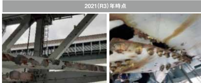
塗膜剥離による腐食 ガセットプレートの破断
