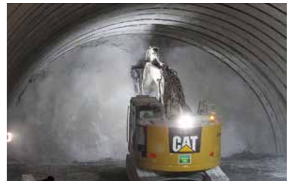
約4年の掘削工を経て青崩峠トンネル（仮称）が貫通した。（提供：国土交通省中部地方整備局飯田国道事務所）
