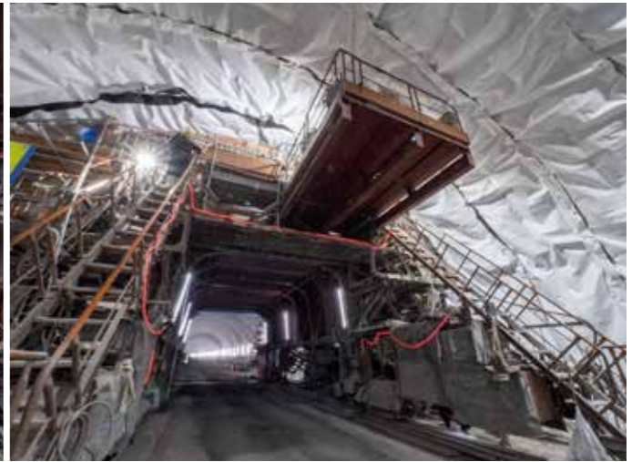
掘削が完了した坑内では引き続きインパート工(左)、覆工(右)が展開されている。更に中央排水や坑門工の施工が待っている。まだまだ気が抜けないと小林作業所長は話す
