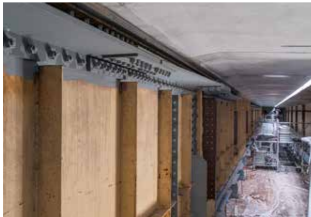
上右／桁下から見上げると新たに施工した中央分離帯部(左側)と今後手を加える旧下り側(右側)の床版の劣化状況が一目瞭然だった。上左・下右／中央分離帯に移動式のクレーンを設置して増設鋼桁を架設。その後、増設桁と既設桁を連結した。(提供：中日本高速道路株) 下左／中央分離帯の鋼桁には既に緻密な補強がなされている
