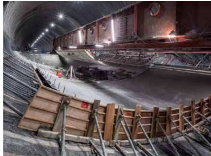
掘削が完了した坑内では引き続きインパート工(左)、覆工(右)が展開されている。更に中央排水や坑門工の施工が待っている。まだまだ気が抜けないと小林作業所長は話す
