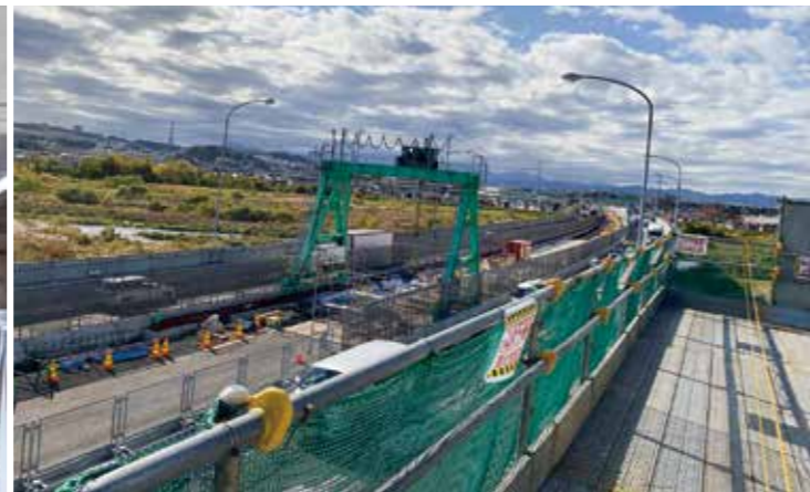
上右／桁下から見上げると新たに施工した中央分離帯部(左側)と今後手を加える旧下り側(右側)の床版の劣化状況が一目瞭然だった。上左・下右／中央分離帯に移動式のクレーンを設置して増設鋼桁を架設。その後、増設桁と既設桁を連結した。(提供：中日本高速道路株) 下左／中央分離帯の鋼桁には既に緻密な補強がなされている
