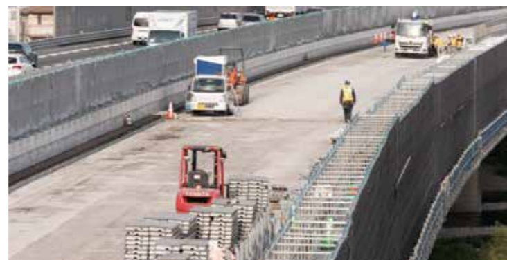
下り線は中央分離帯にシフトされ、かつての下り線では設備の撤去などが行われていた。今後、中央分離帯と同様の手順で更新工事が始まる
