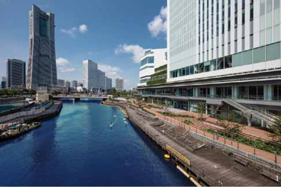
1. 桜木町駅と横浜市役所をつなぐ人道橋 2. アトリウム 3. 議場
